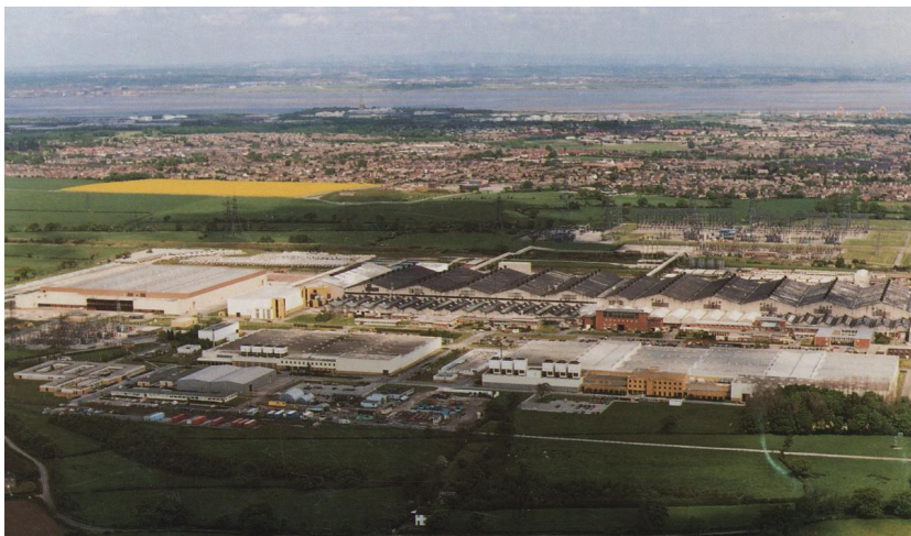
Рис.5.4. Панорама газоцентрифужного завода в Кейпенхорсте (объединение URENCO)
