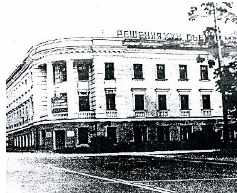
Здание управления комбината
