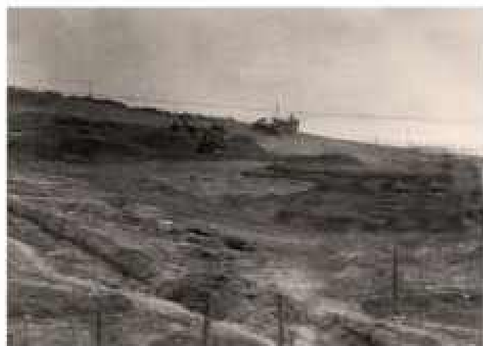
Место строительства Дома культуры
