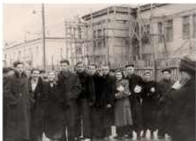
Здание АТС в лесах
