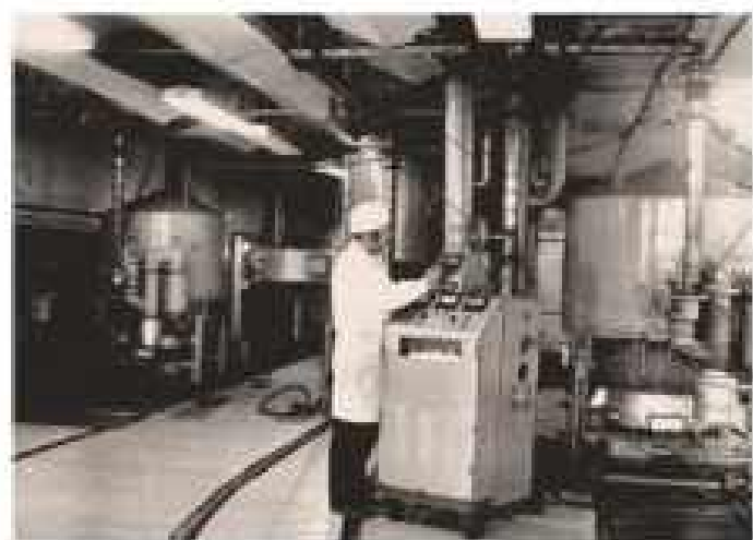
Измерение вакуума в объемах установки СУ-20
