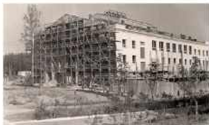
Строительство ДЗ «Октябрь»
