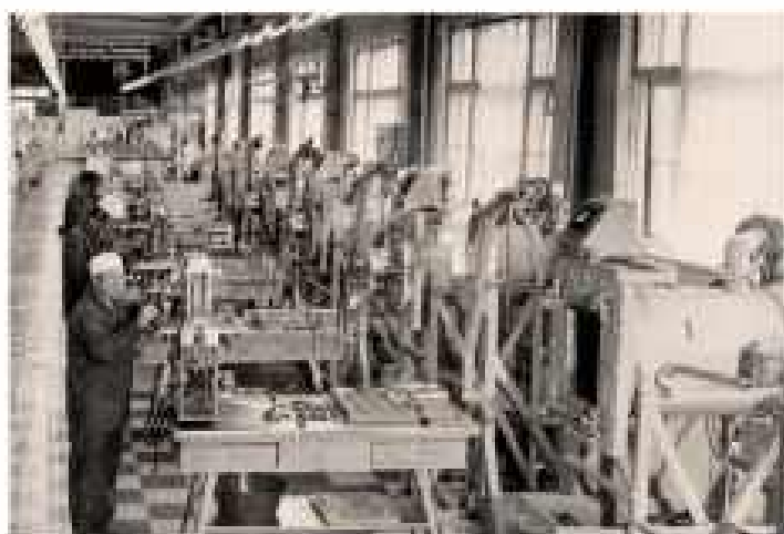
Галерея сборки узлов 10 и 11 — источника и приемника изотопов
