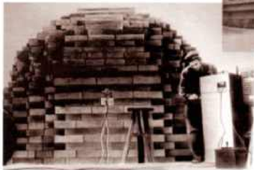
Первый исследователь- ский уран-графитовый реактор Ф-1, 1946 г.
