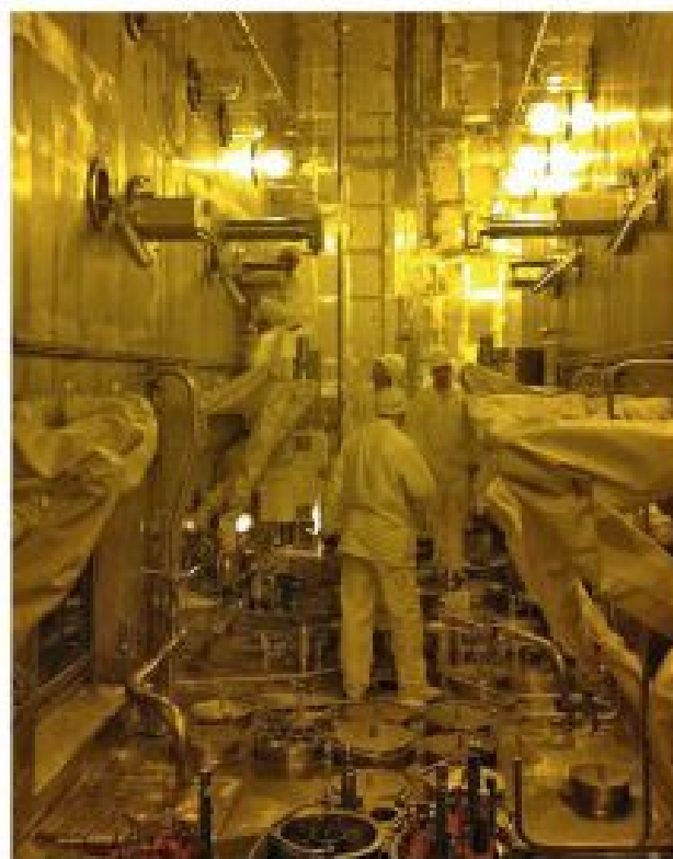
Работа персонала подразделения в защитной камере Ленинградской АЭС по монтажу регистраторов АСОТУиК ЯМ
