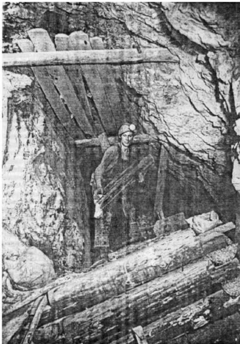
Рис. 28. Подготовительные работы в забое урановой шахты
