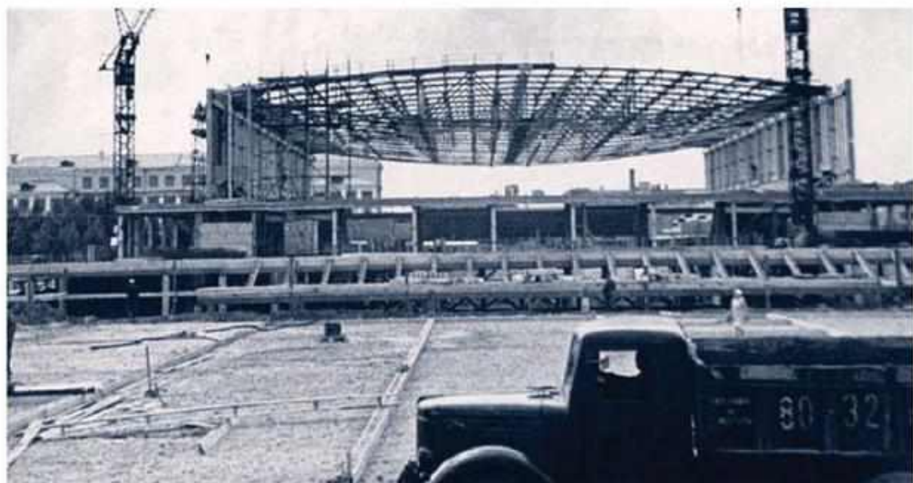
Строительство Ледового дворца спорта «Кристалл»
