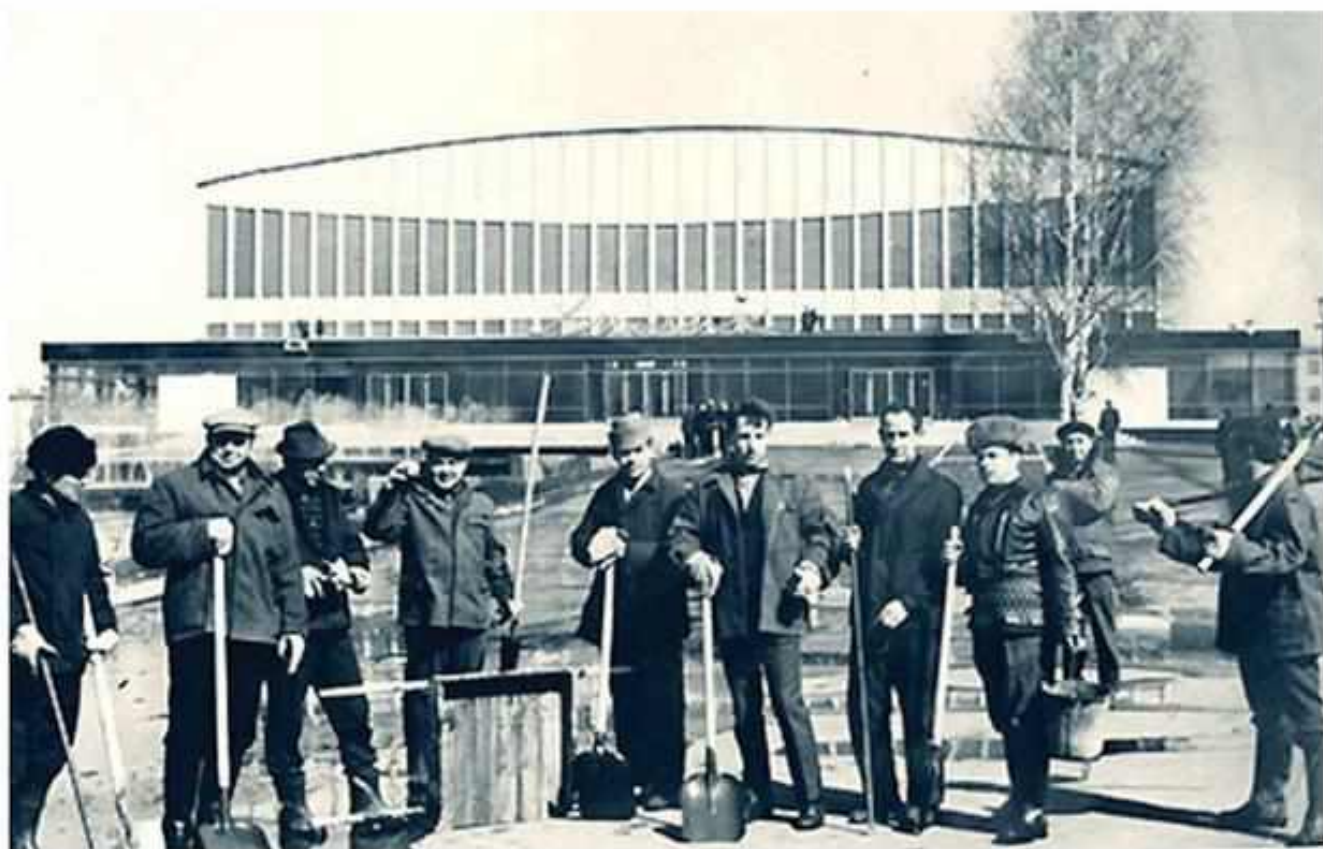
Строительство Ледового дворца спорта «Кристалл»
