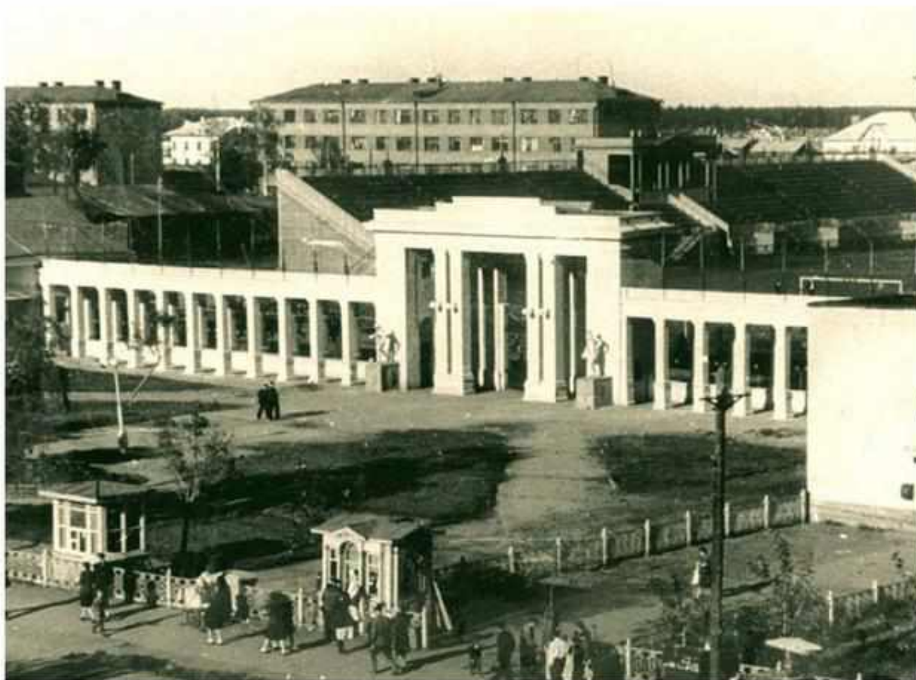
Главный вход на заводской стадион
