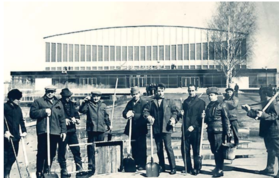
Строительство Ледового дворца спорта «Кристалл»
