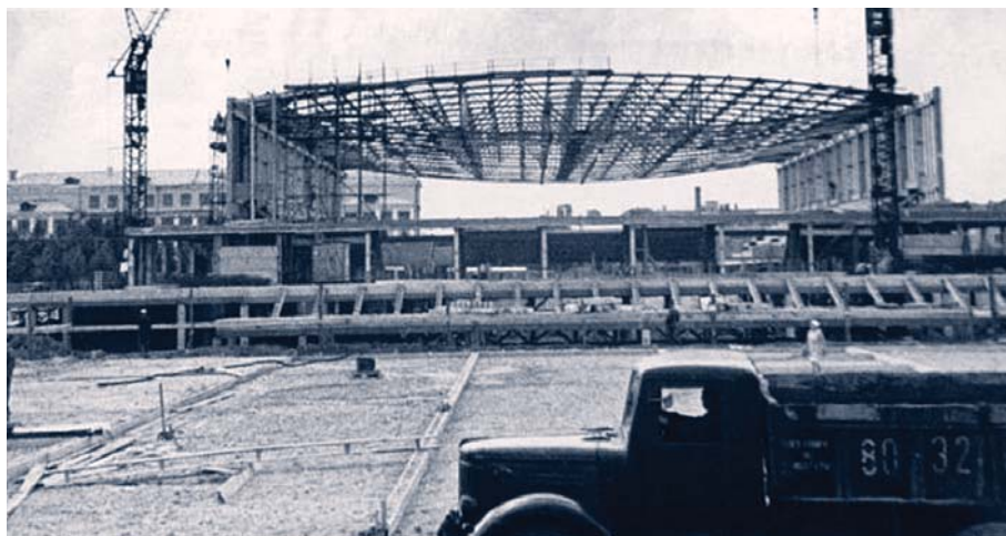
Строительство Ледового дворца спорта «Кристалл»
