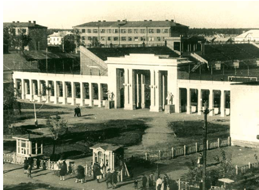
Главный вход на заводской стадион
