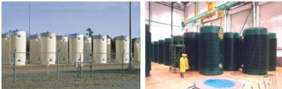
Рис. 17.4. Примеры хранилищ ОЯТ с использованием двухцелевых контейнеров
