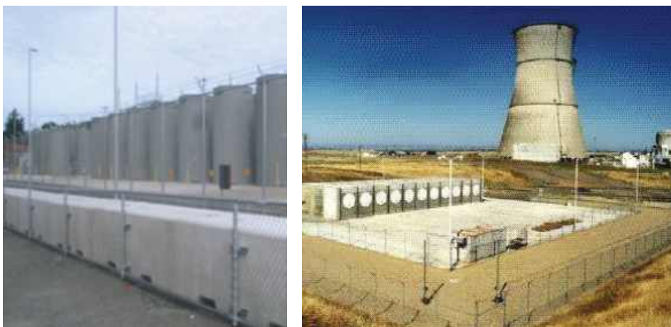
Рис. 17.3. Примеры основных типов вентилируемых хранилищ ОЯТ
