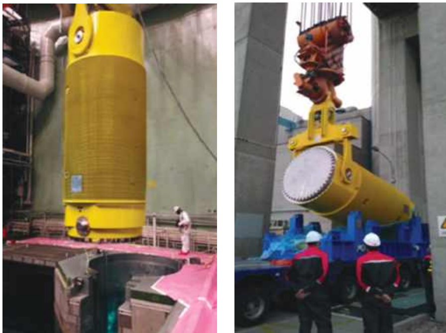
Рис. 17.1. Современный ТУК-153 на энергоблоке АЭС с РУ ВВЭР-1000
