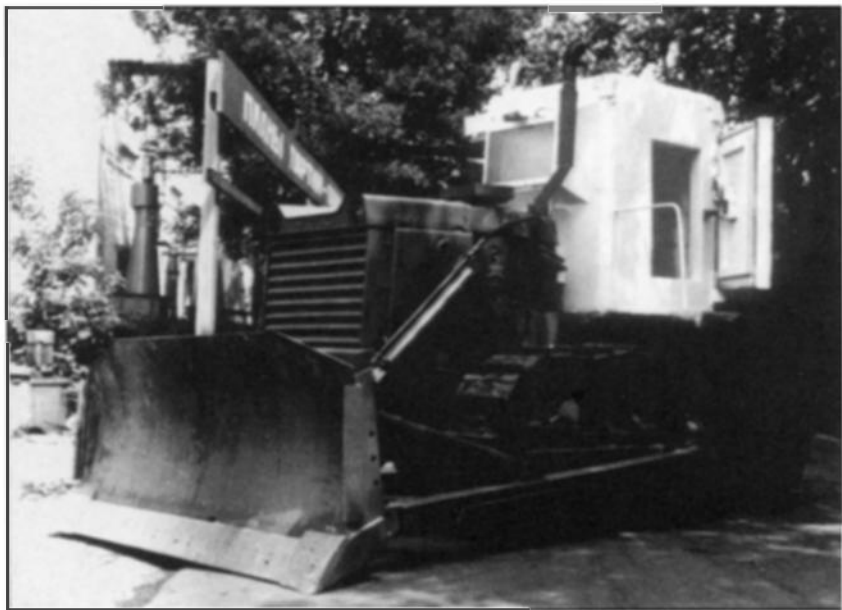
Бульдозер оснащенный защитной кабиной. Чернобыль, июнь 1986 г.
