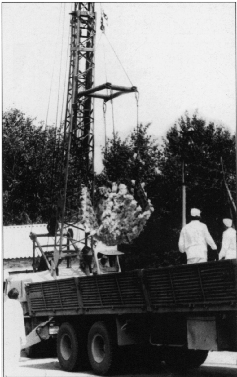
Загрузка клеевых захватов в контейнер для отправки на ЧАЭС Чернобыль, июль 1986 г.
