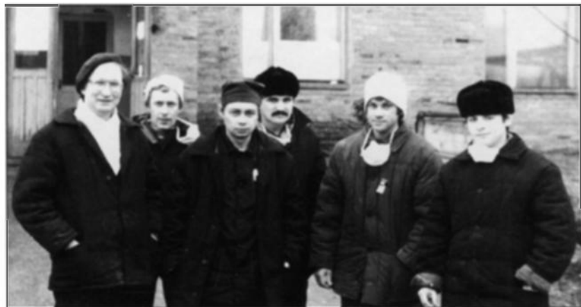
А.П. Сафьян, Е.М. Осин и группа химиков-киевлян на площадке для герметизации конструкций «Укрытия». ЧАЭС, октябрь 1986 г.
