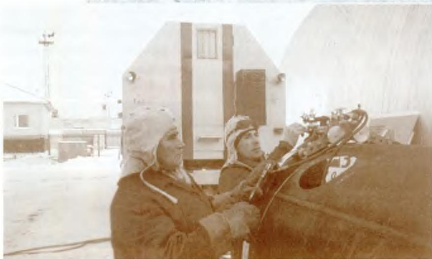
*Оборудование для кислородной резки труб*
