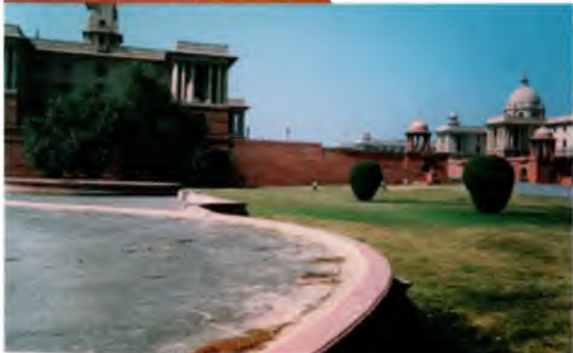
Часть зданий правительственного комплекса. Дели
