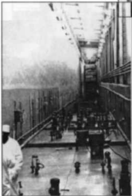
Монтажный зал завода ДБ (завод 35).
