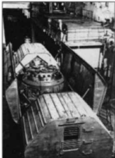
ТУК 6 - транспортно-упаковочный комплекс для перевозки отработанного ядерного топлива ВВЭР 440.
