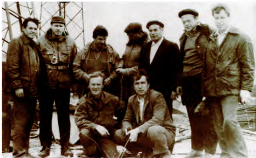
Сотрудники ОКСа на строительном объекте
