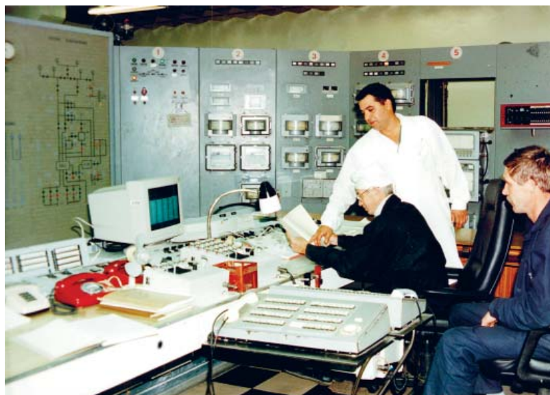
Пульт начальника смены стенда КВ-1
