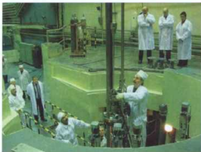
Загрузка первой ТВС в реактор ИБР-2 после модернизации
