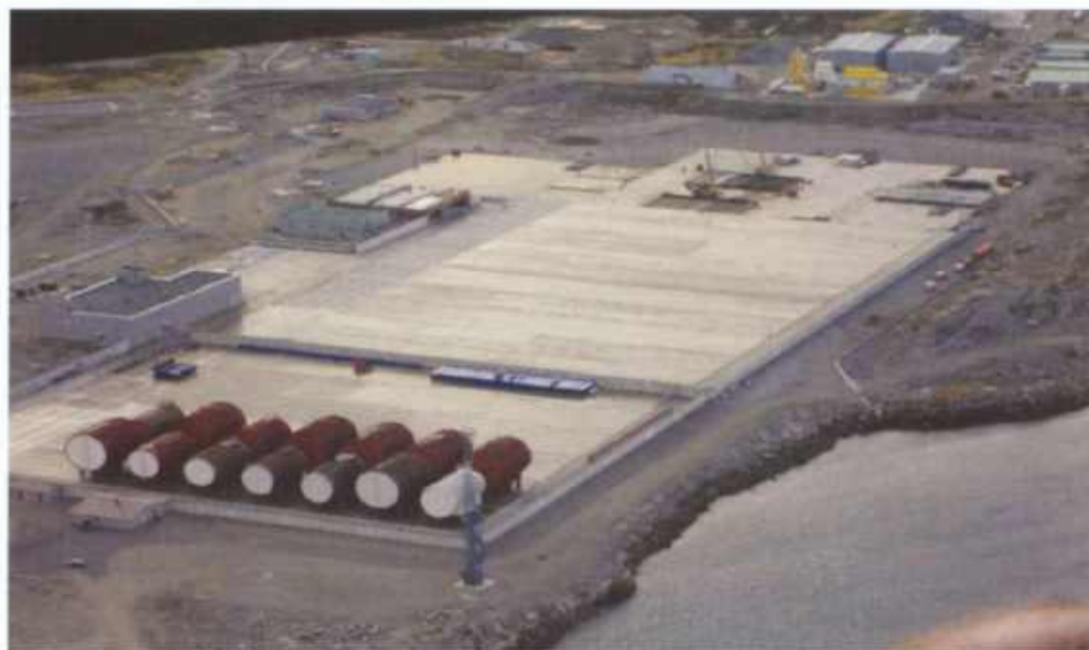
Долговременное хранение реакторных отсеков на береговой площадке пункта долговременного хранения РО «Сайда»
