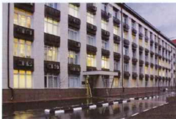
3-й корпус после ремонта
