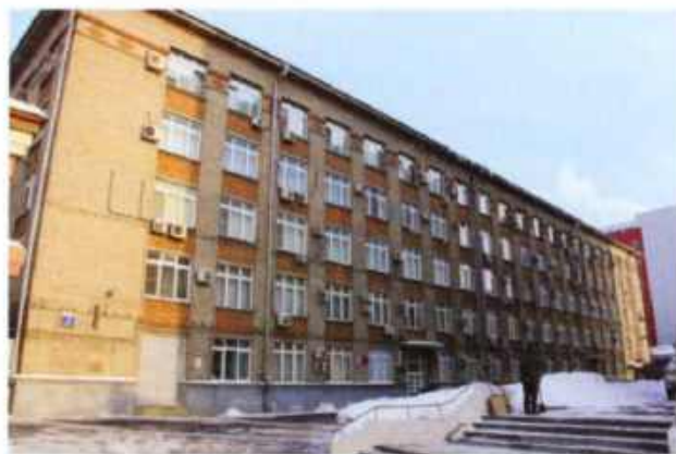
3-й корпус до ремонта
