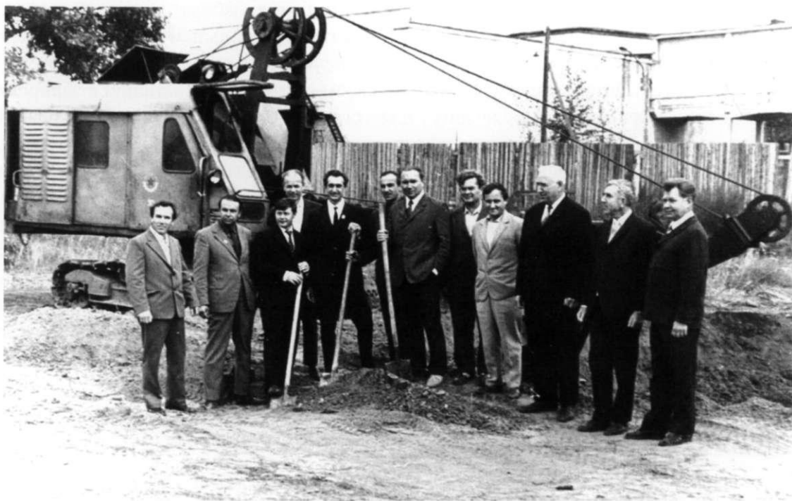
Начало строительства здания установки «Орёл»
