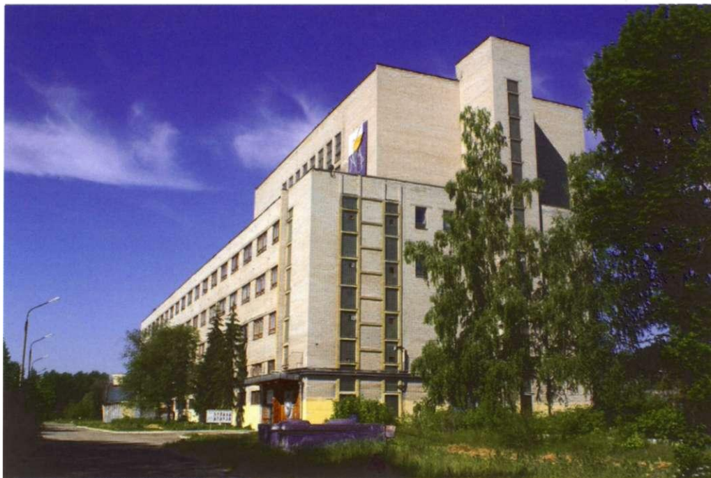
Внешний вид здания реактора ВК-50
