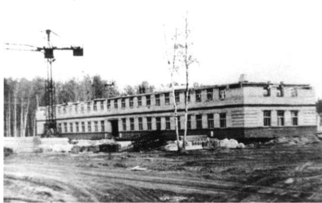
Строительство здания 120 (1960 год)
