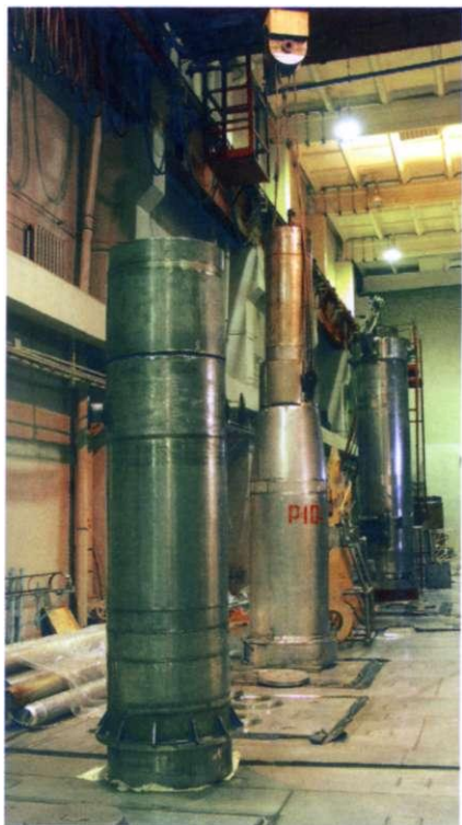
Общий вид транспортных контейнеров
