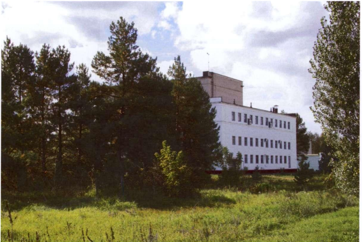
Внешний вид здания 134 комплекса по обращению с радиоактивными отходами
