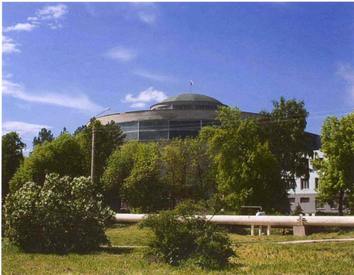
Внешний вид здания реактора МИР
