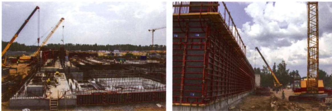
Строительство полифункционального исследовательского радиохимического комплекса
