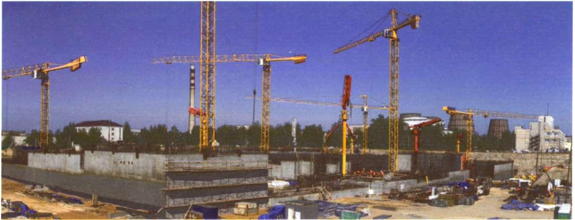
Площадка сооружения реактора МБИР (август, 2016 год)
