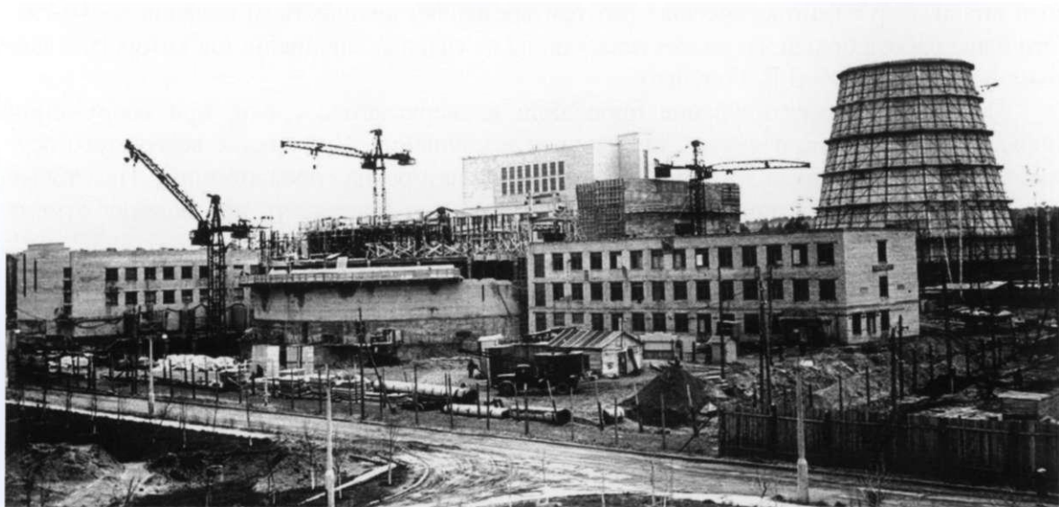
Строительство здания реактора МИР
