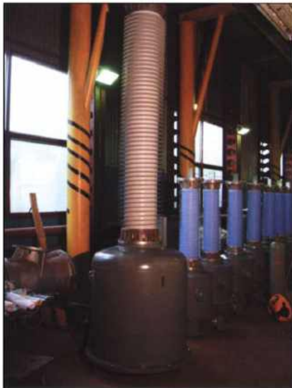
Измерительные элегазовые трансформаторы на- пряжения 110 и 220 кВ
