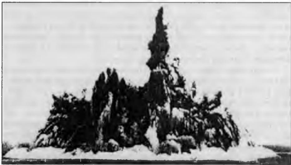
Рис. 6.10. Развитие выброса грунта и облака группового ядерного взрыва «Тайга» (3x15 кт); общий вид через 6 сек после детонации зарядов
