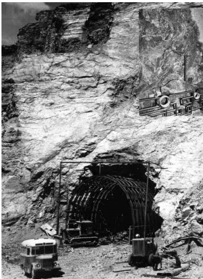
Начало строительства въезда на комбинат
