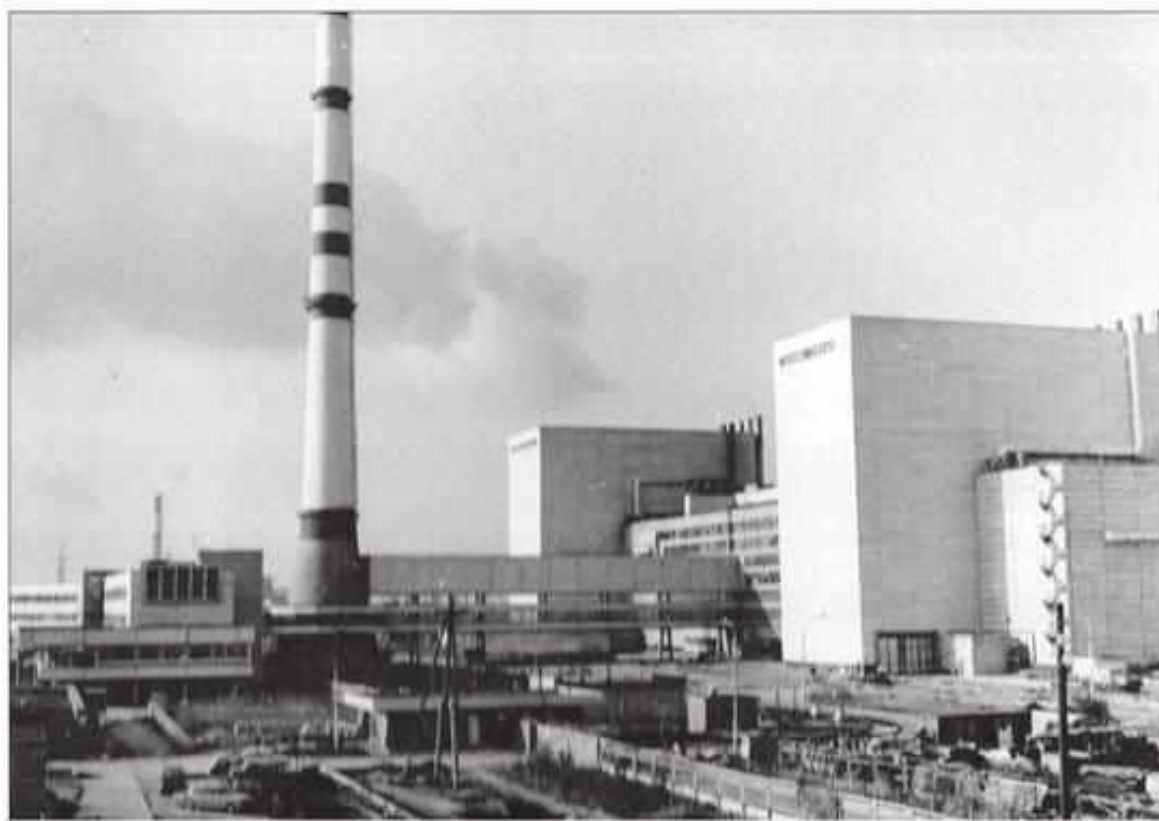
Ленинградская атомная станция
