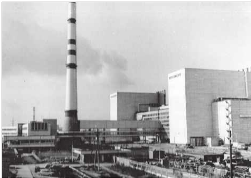
Ленинградская атомная станция
