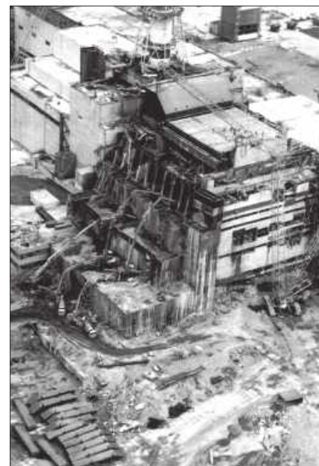
Состояние строящегося «Укрытия» перед установкой балки «Мамонт». Октябрь 1986 г.
