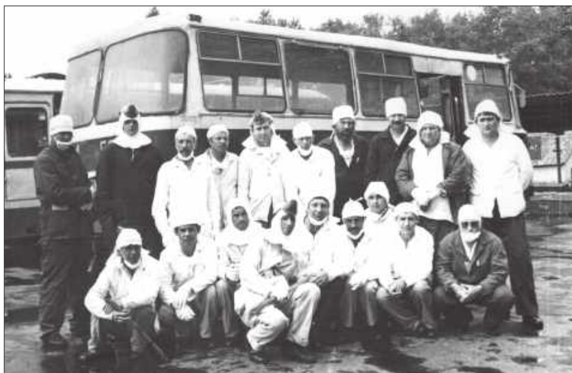
Первые чернобыльцы Минсредмаша треста ПО «Энергоспецмонтаж», направленные для работы по изготовлению теплообменника под ректором 4-го энергоблока. ЧАЭС, май 1986 г.
