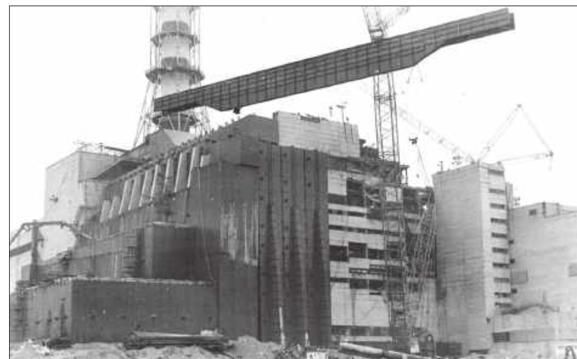
Подъем балки «Мамонт» на пределе грузоподъемности. 2 ноября 1986 г.
