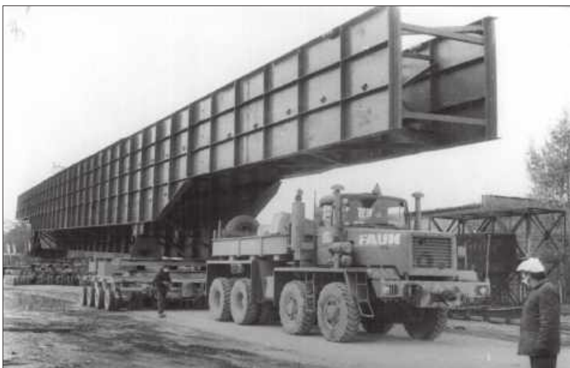
Доставка к месту монтажа балки «Мамонт» длиной 70 м, высотой 4 м и весом вместе с траверсой 180 т. Октябрь 1986 г.
