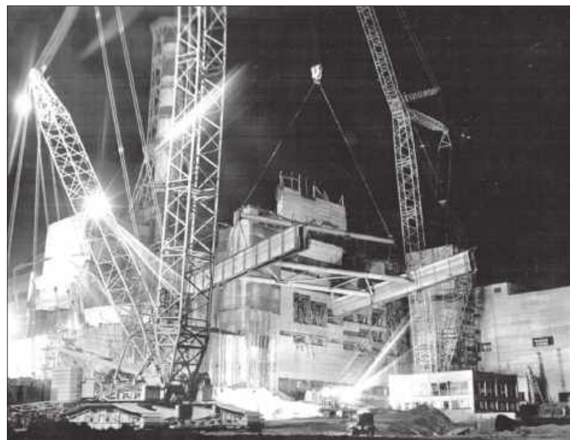
Балка «Самолет» над разрушенным блоком ночью перед установкой в проектное положение. 22 сентября 1986 г.
