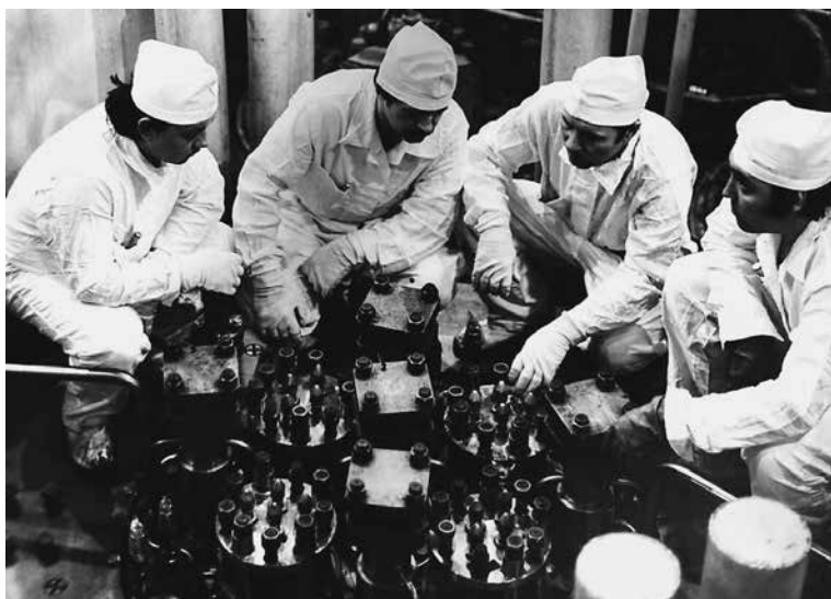
Киповцы «колдуют» в центральном отсеке (ЦО)
