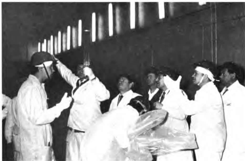
1975 г. Физический пуск 2-го блока. Осмотр кассет (ТВС) перед загрузкой в реактор
