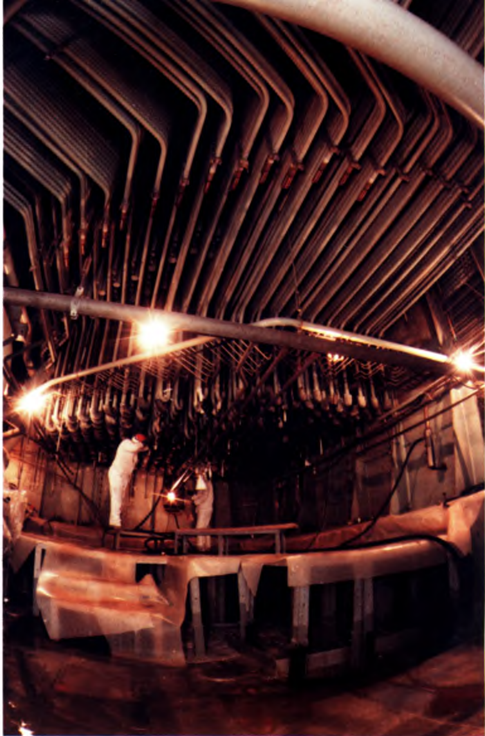
Ремонт нижних коммуникаций реактора
