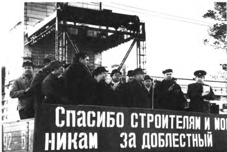
1972 г. Митинг по случаю сдачи центрального зала под монтаж ТК. На трибуне: И.И. Семькин, Е.К. Бычков, В.П. Муравьев, В.Н. Латий, К.К. Коблицкий и др.
