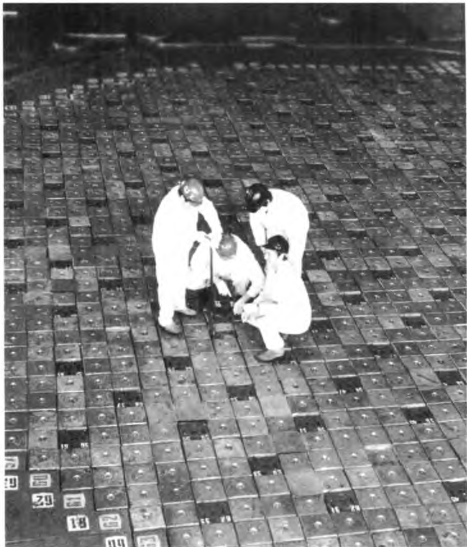
Центральный зал Ленинградской АЭС
