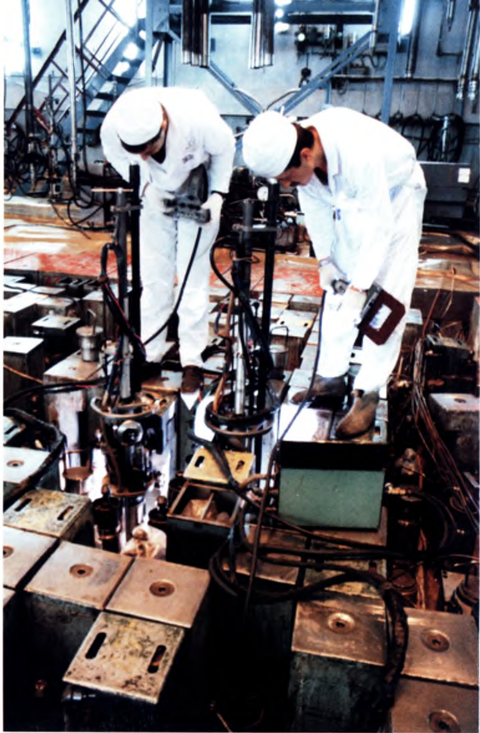
Автоматическая приварка обоймы верхнего тракта ТК
