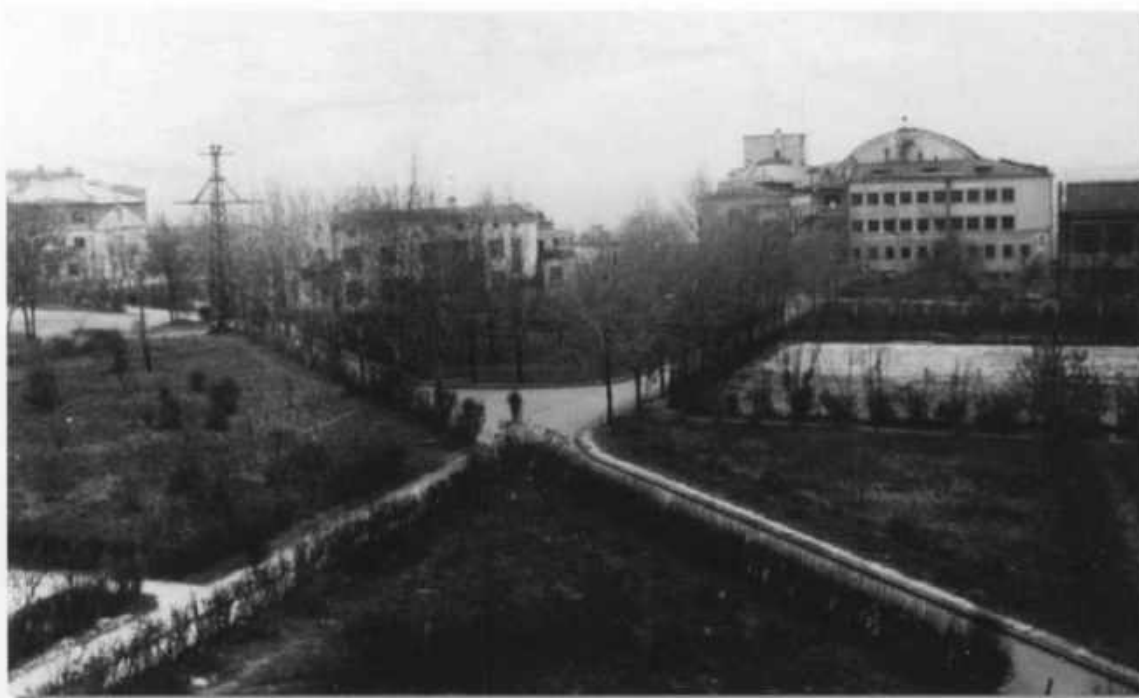
Панорама территории УФИ: справа высоковольтный корпус с куполом генератора Ван де Граафа и с жилой пристройкой для сотрудников
