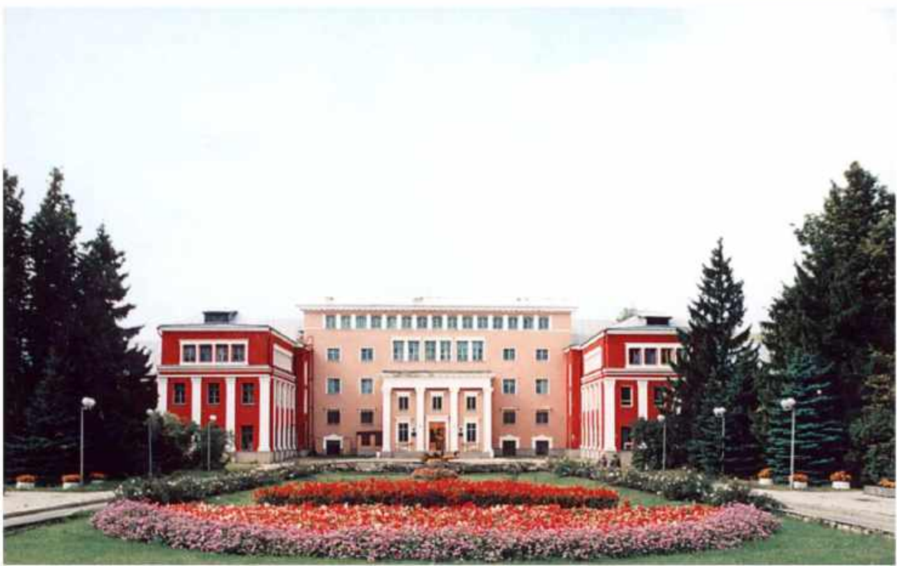
Главный корпус ГНЦ РФ-ФЭИ, 2003 г.
