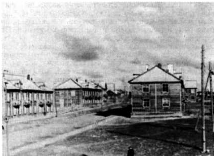
Первые деревянные новостройки. Конец 40-х годов
