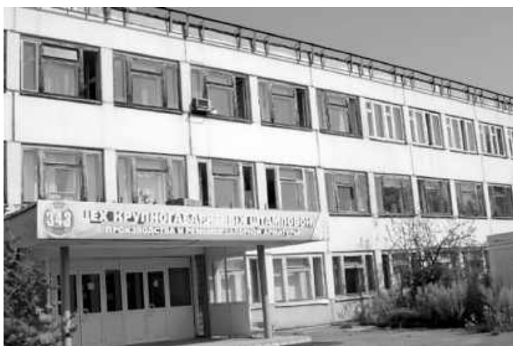
Административный корпус здания 377
