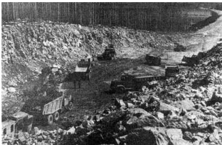
Строительство автомагистрали Свердловск - Серов
