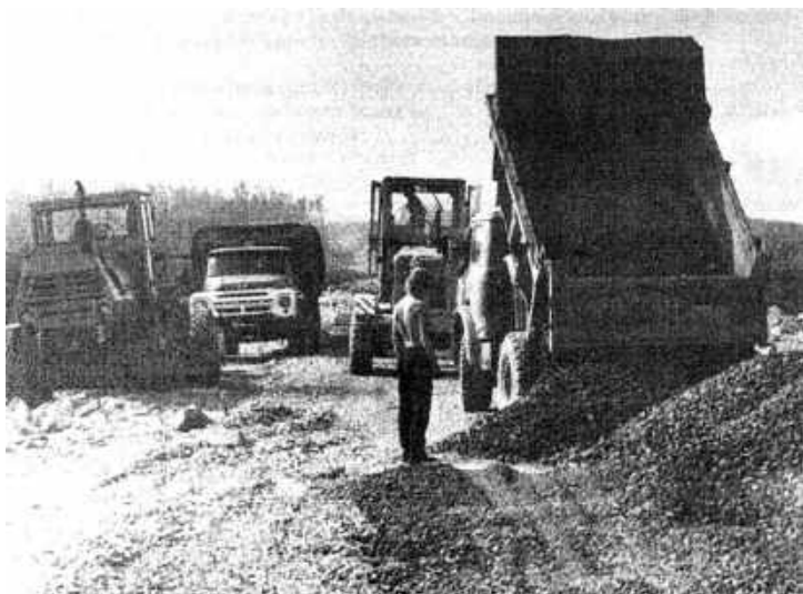
Укладка дорожной «одежды»
