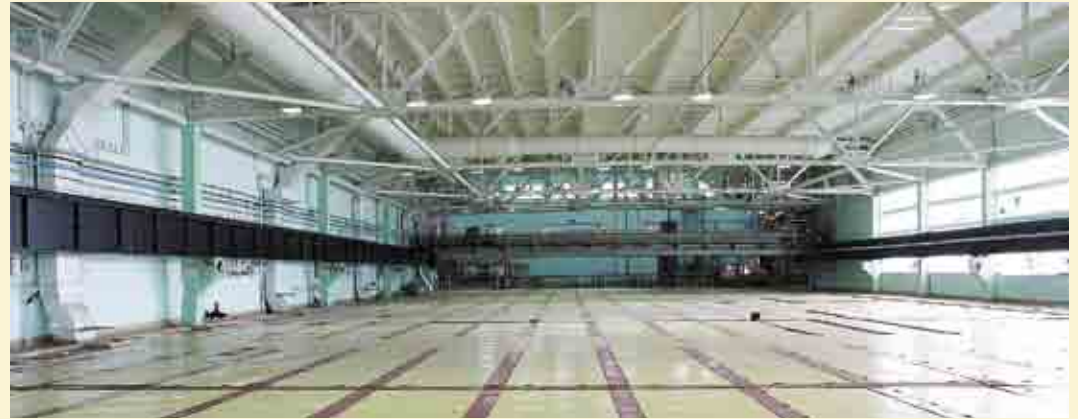
Общий вид бассейна «мокрого» хранения — зеркало воды под стальными листами
