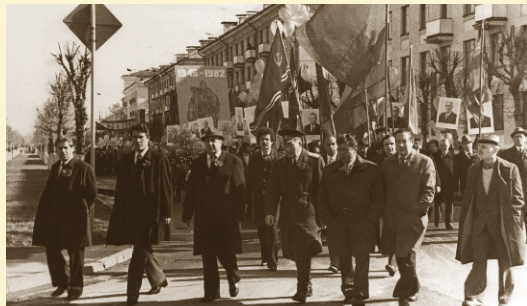
Благодаря мощной строительной базе в городе и на промобъектах можно было строить объекты любой сложности. 1982 год, во главе первомайской колонны строителей Красноярска-26 П. Т. Штефан, П. Д. Даниловский, В. И. Панус (из фотоархива В. И. Пануса)
