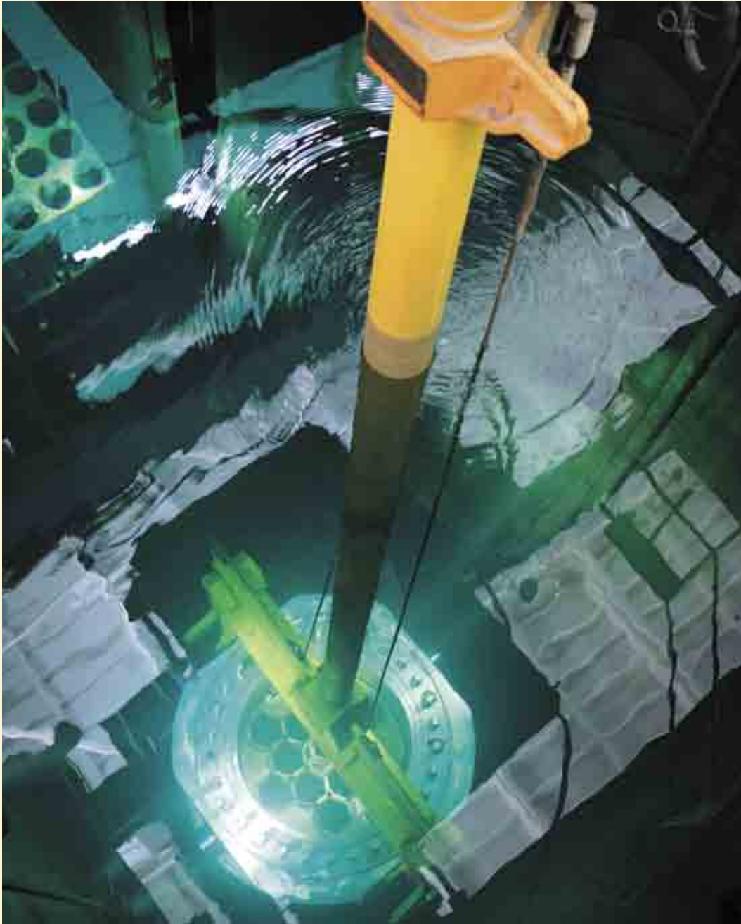
Узел перегрузки ОТВС — сборки из транспортного контейнера перемещаются в чехол хранения, толщина воды над сборкой во время операции не менее 2,5 метра
