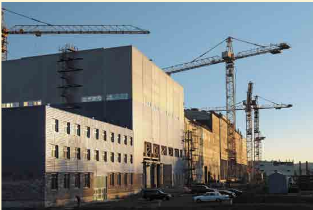
В октябре 2009 г. строительство ХОТ-2 («сухого» хранилища) навестило директивный график
