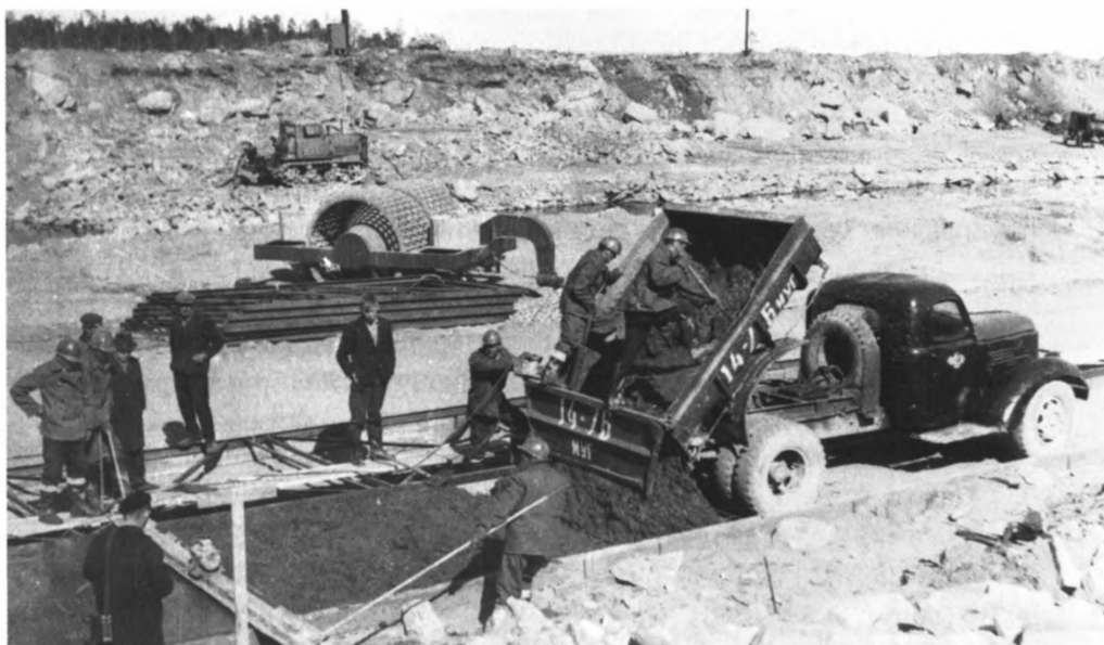
Укладка первого кубометра бетона в основание АЭС
