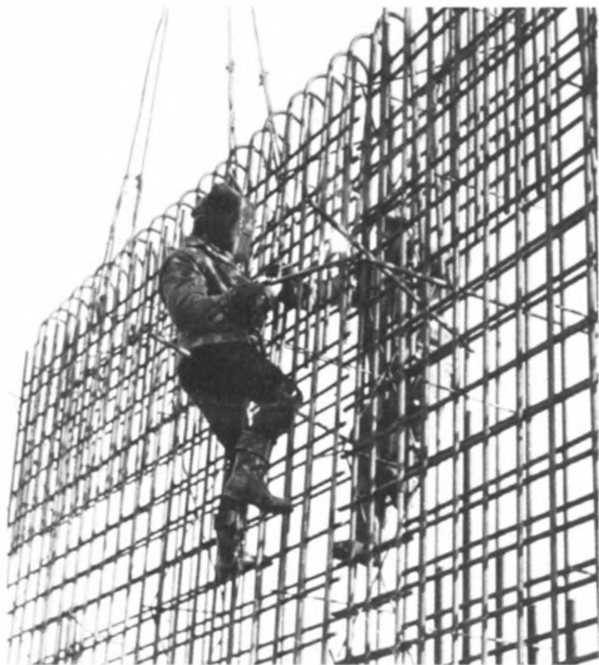
Электросварщики на арматуре спецкорпуса 1
