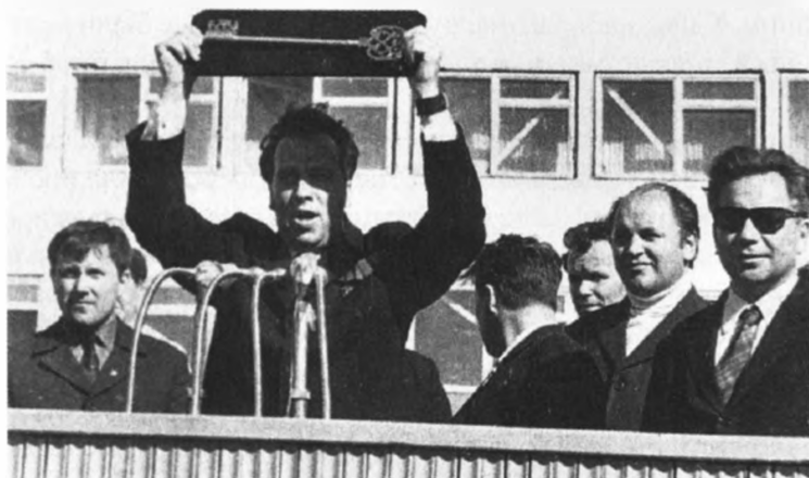
На митинге, посвященном пуску первого энергоблока станции. Начальник строительства А.С. Андрущечко передает эксплуатационникам символический ключ от КАЭС
