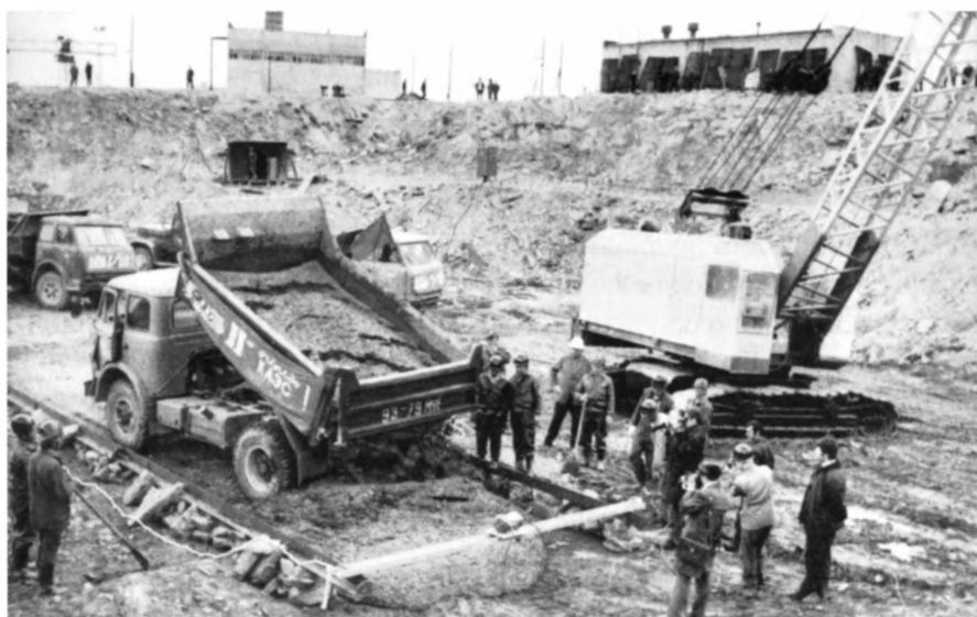
Укладка первого бетона второй очереди
