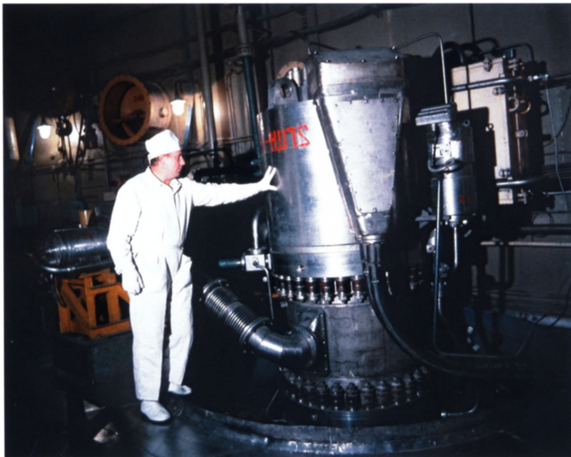
Палуба ГЦН. Состояние технологического оборудования, ход некоторых процессов контролирует не только автоматика, но и человек
