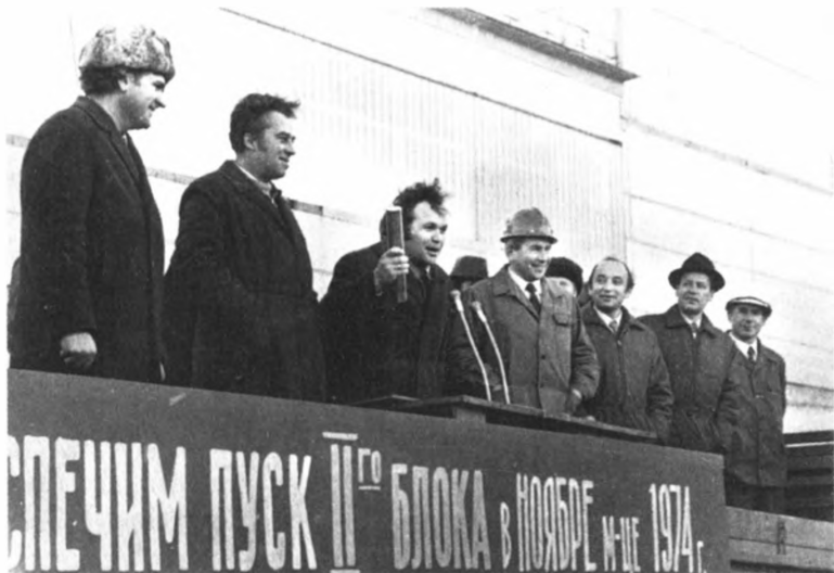
Строители приняли обязательство досрочно вести в эксплуатацию II блок КАЭС
