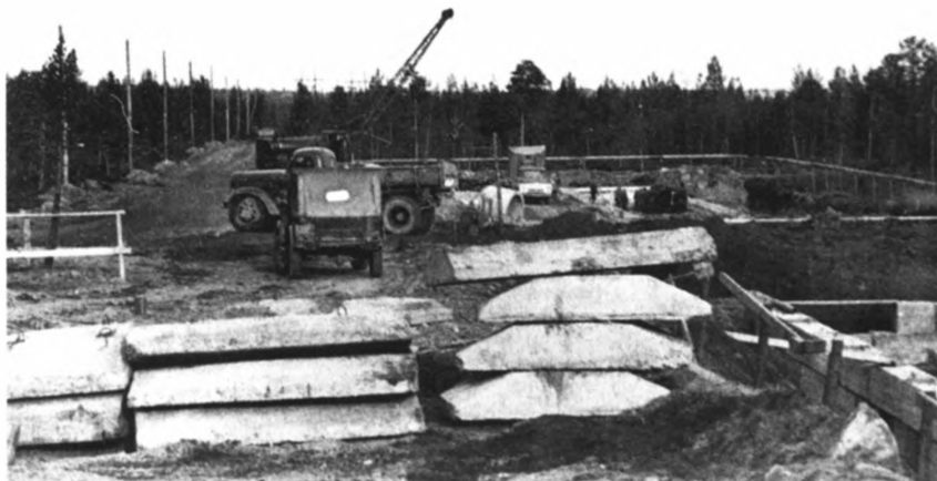
Закладка фундамента первого жилого дома
