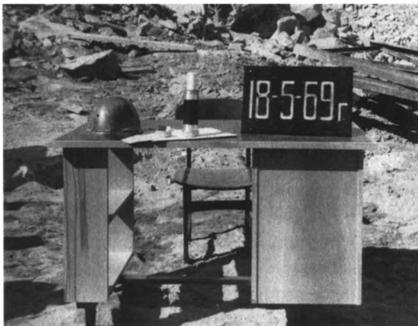
Памятная капсула с текстом о начале строительства, заложённая с первым бетоном
