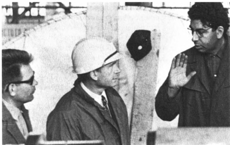
Начальником электрического цеха в то время был А. А. Штернгуз
