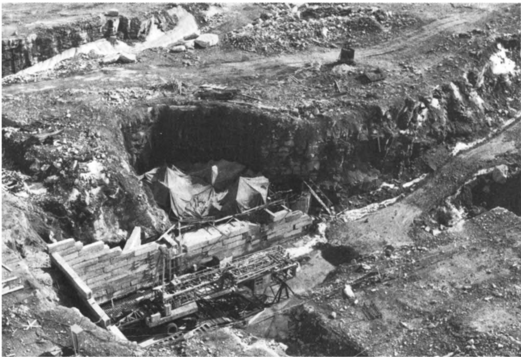
Работы на котловане шахты реактора №1 и узла борного регулирования
