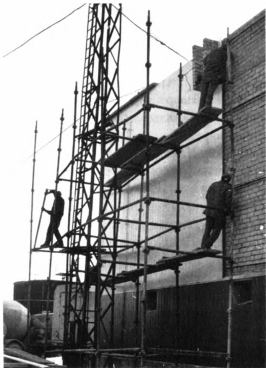
Реконструкция бывшей столовой. После ремонта здесь разместится УТП
