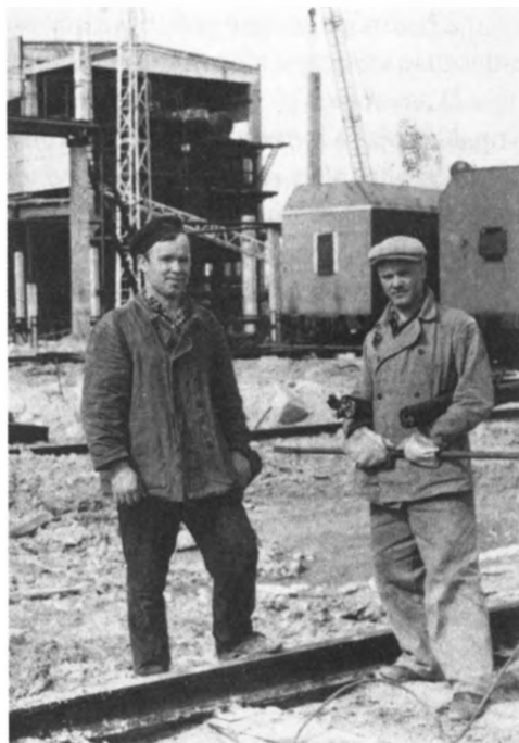
Слева, бригадир «морской бригады» монтажников Н. Ф. Климкин
