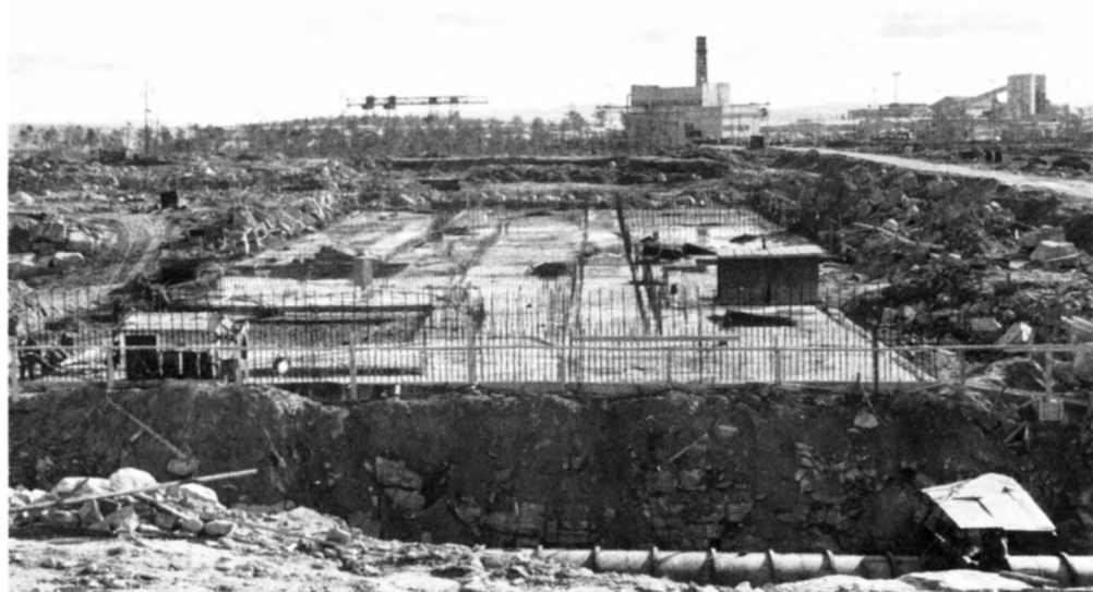
Фундамент спецкорпуса 1. 1971 год
