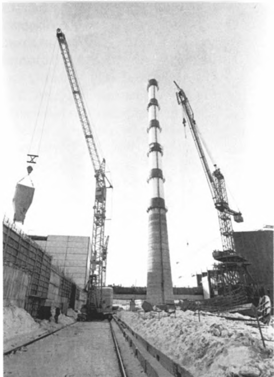
Продолжается строительство второй очереди КАЭС
