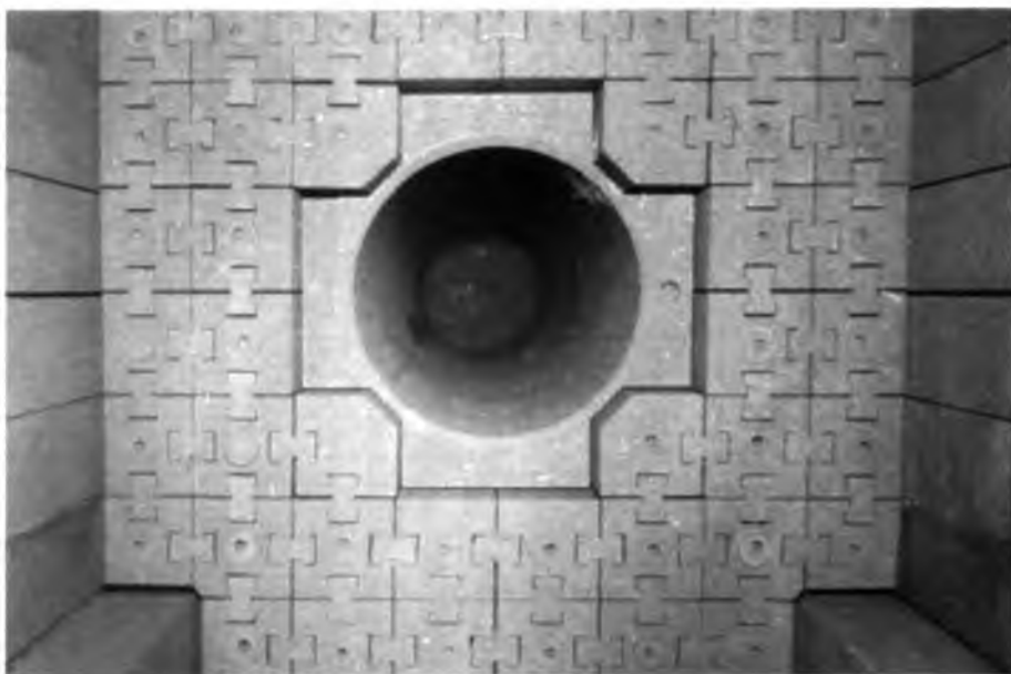
Центральный канал реактора ИГР
