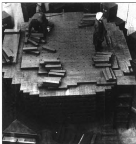
Сборка реактора Ф-1 в Лаборатории №2, 1946 год
