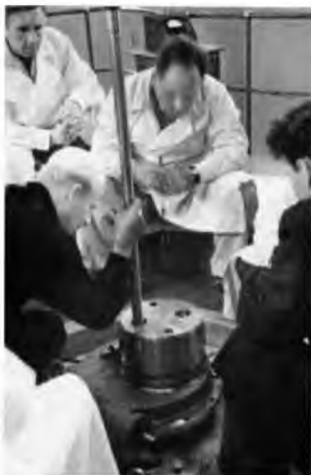
Установка тепловыделяющей сборки в активную зону быстрого реактора БР-5 во время «сухого» пуска. В белых халатах О.Д. Казачковский и М.С. Пинхасик, в черных — В.Н. Лебедев и Н.Н. Аристархов. Лаборатория «В», июль 1958 г.
