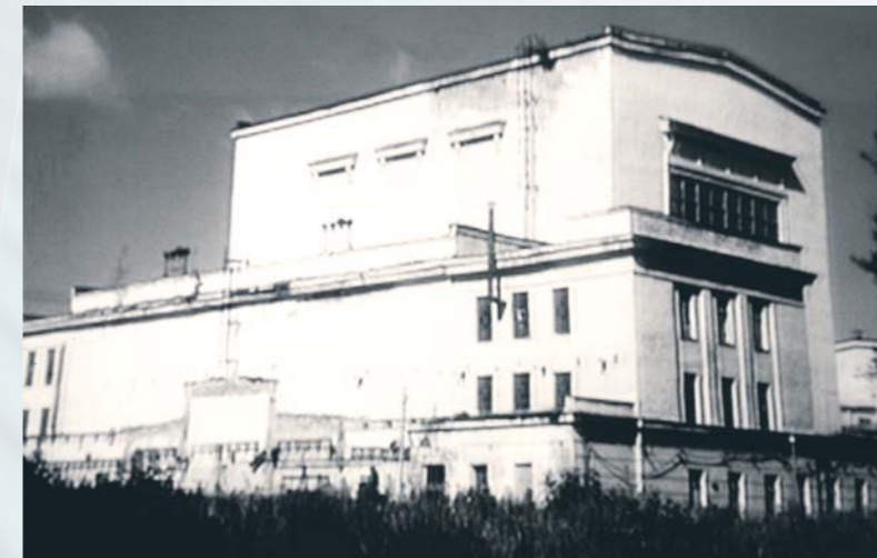
Здание первого промышленного реактора.
