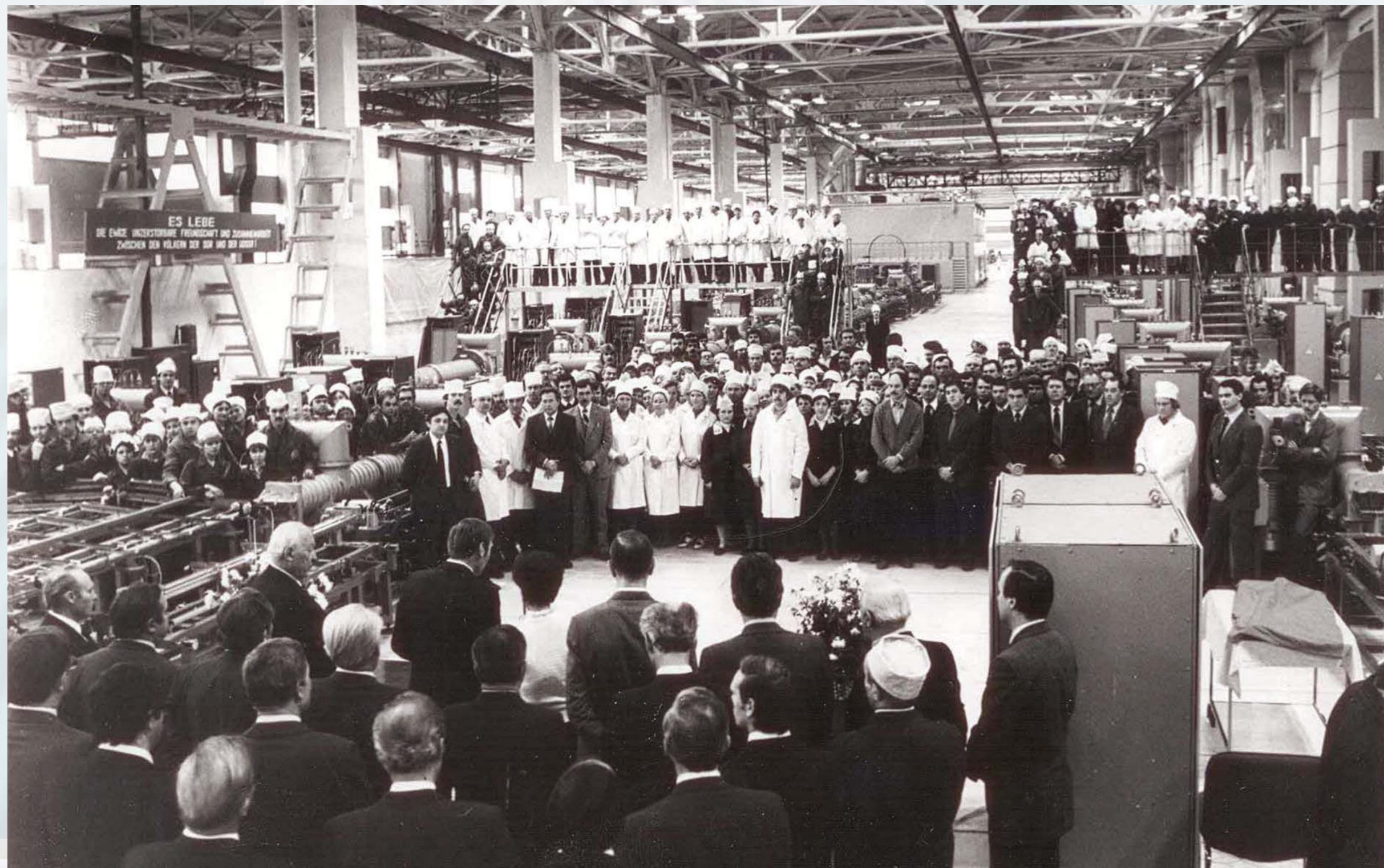
Митинг в цехе № 46 по случаю ввода в эксплуатацию немецкой линии.
