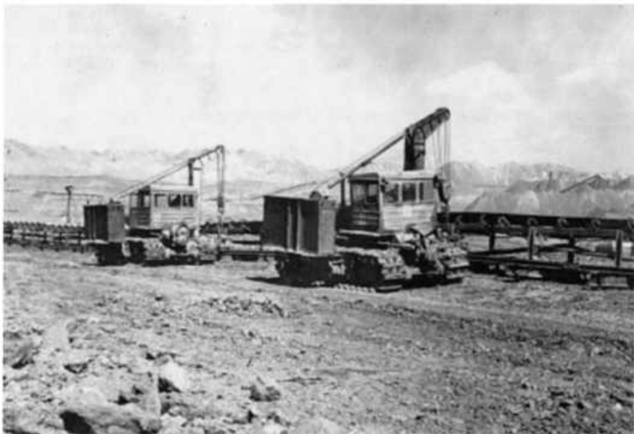
Передвижка забойного конвейера турнодозерами
