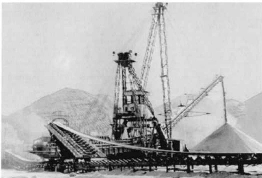
Шагающий отвалообразователь ОШ-105/1500 в работе на карьере № 5
