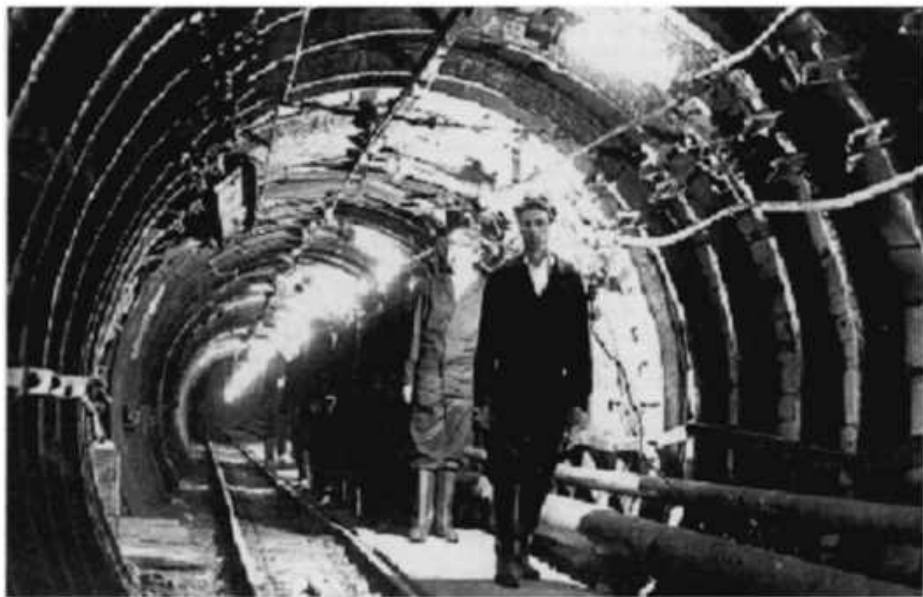
Рудник № 6. Штрек закрепленный кольцевой крепью из СП
