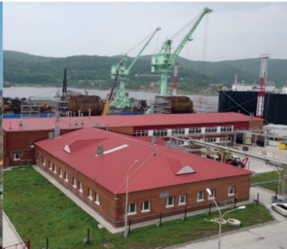
Подготовка аварийных реакторных отсеков к изоляции
