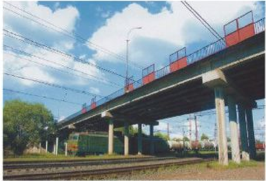
Виадук через магистральные железнодорожные пути. Сооружён в 1989 г.
