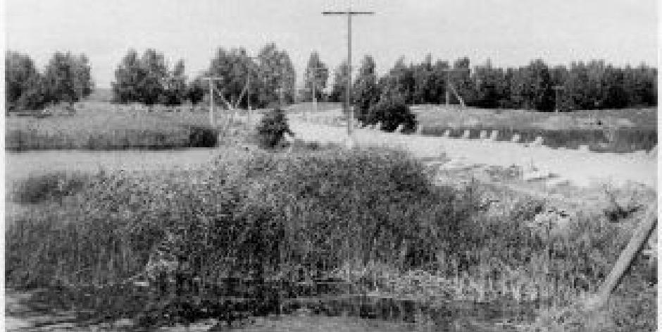
Редкое фото так называемой «лежнёвки» – грунтовой дороги с «усовершенствованным покрытием» – бревенчатым настилом. Участок на снимке ведёт через болото, поэтому усилен бетонными балками, скрепляющими конструкцию. Именно такие дороги вели к «соседним населённым пунктам». Примечательно, что в документах они (Насли, Кыштым) имелись так, в целях секретности, и назывались
