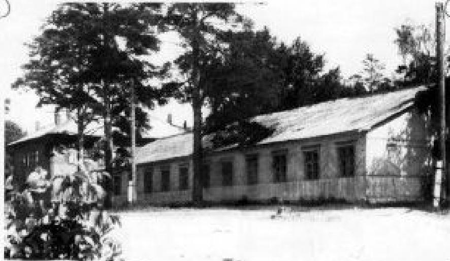
Озёрск 50-х. Хорошо видна щитовая конструкция деревянных зданий.
