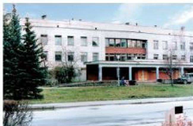
Детская поликлиника (здание введено в эксплуатацию в 1971 году)
