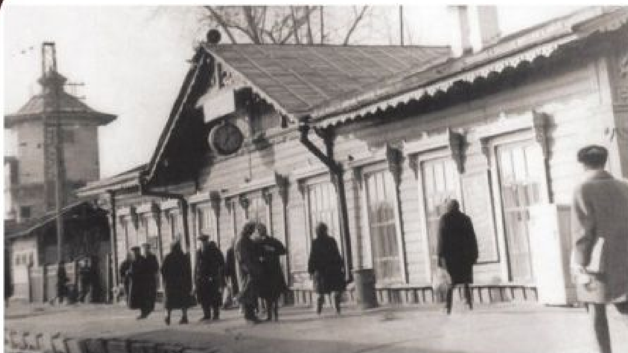
Вокзал станции Верх-Нейвинск, построенный в 1918 году
