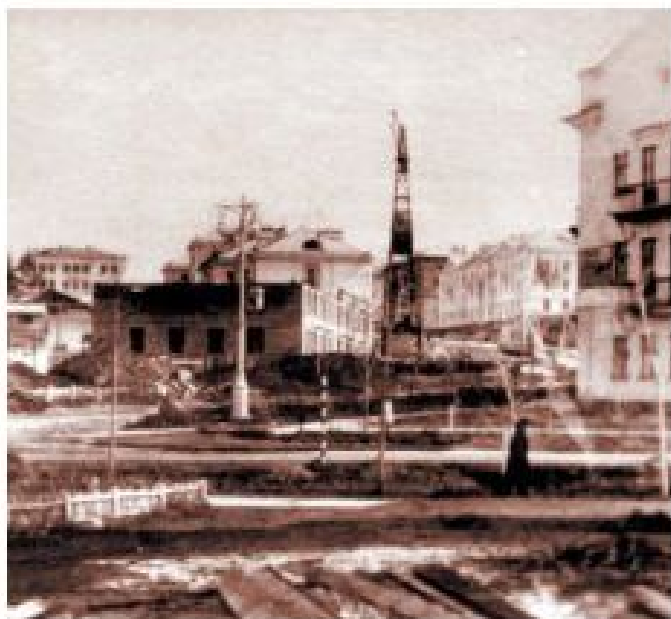
Строительство домов на улице Привокзальной (Гагарина)
