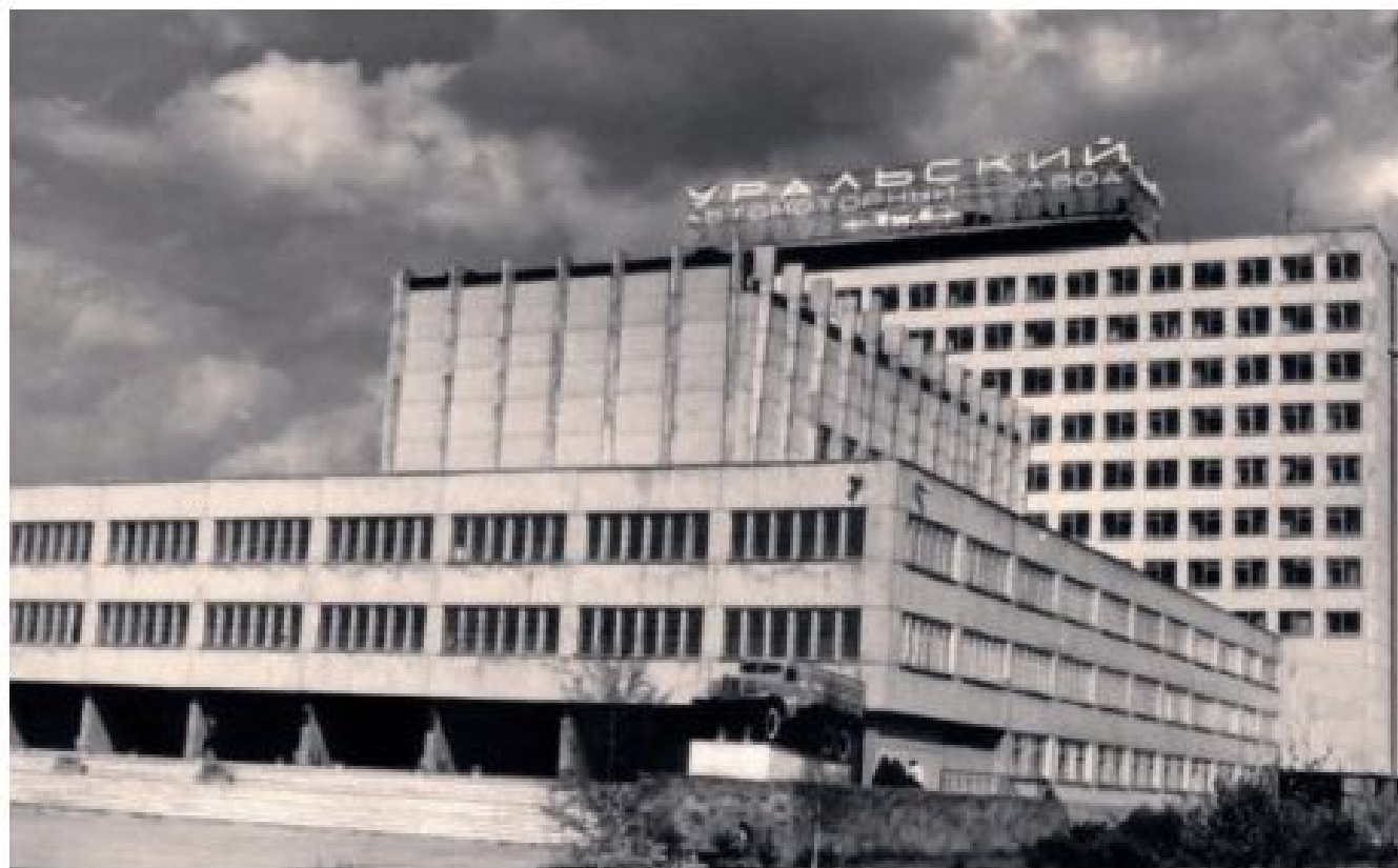
Уральский автомобильный завод. Административный корпус. Здание № 402
