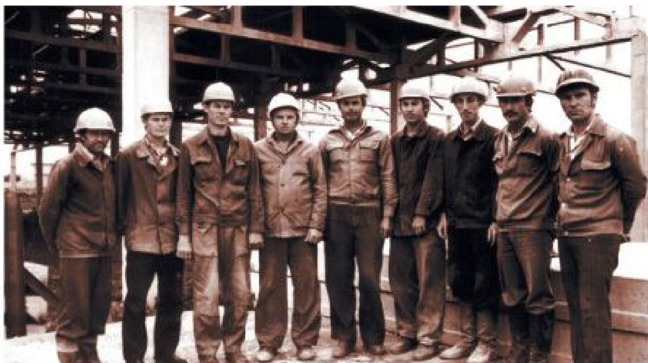
Бригада плотников-бетонщиков СМУ-4
