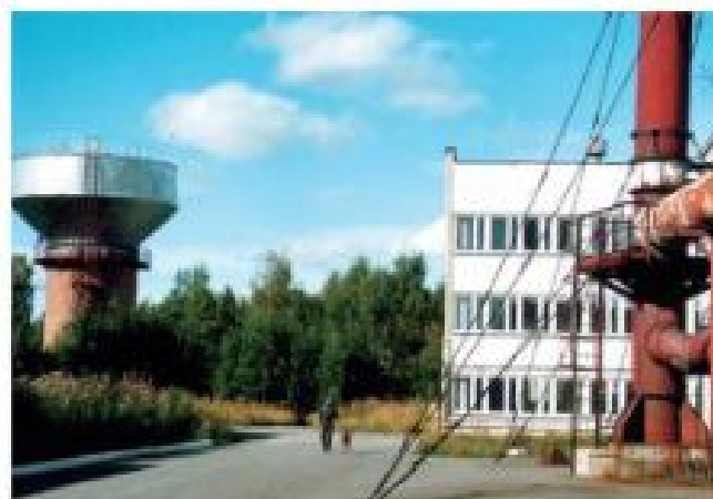
Насос-фильтрационная станция (НФС)
