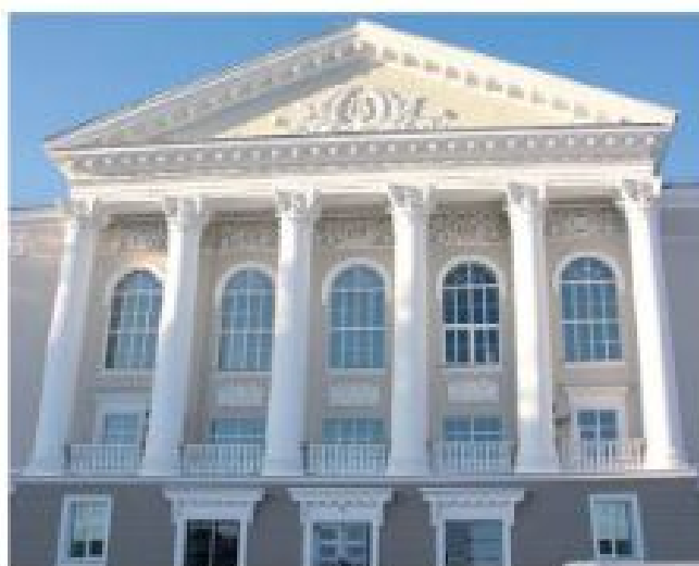
Дом культуры УЭХК после капитального ремонта
