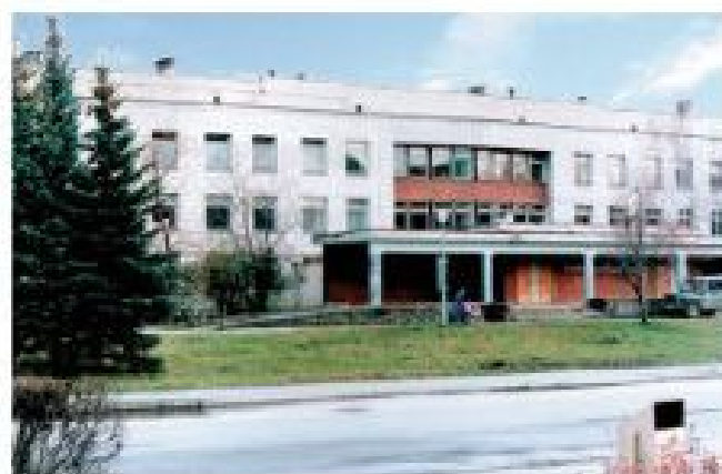
Детская поликлиника (здание возведено в эксплуатацию в 1971 году)
