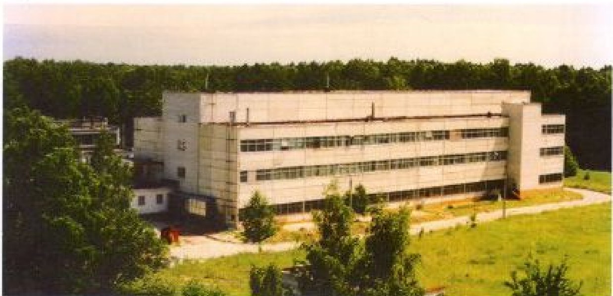
Общий вид здания комплекса
