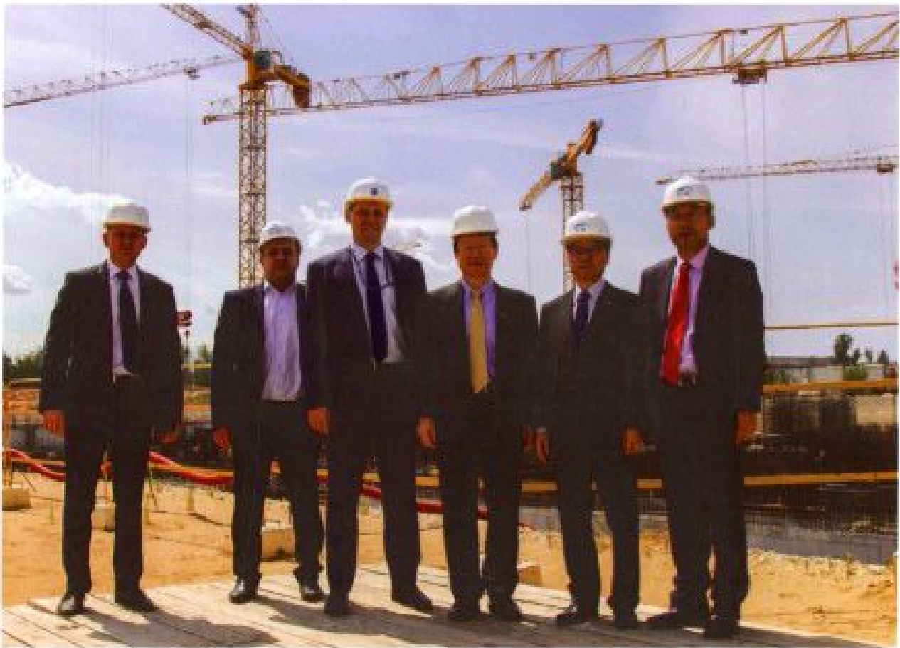
Визит корейской делегации на строительную площадку реактора МБИР (2016 год)
