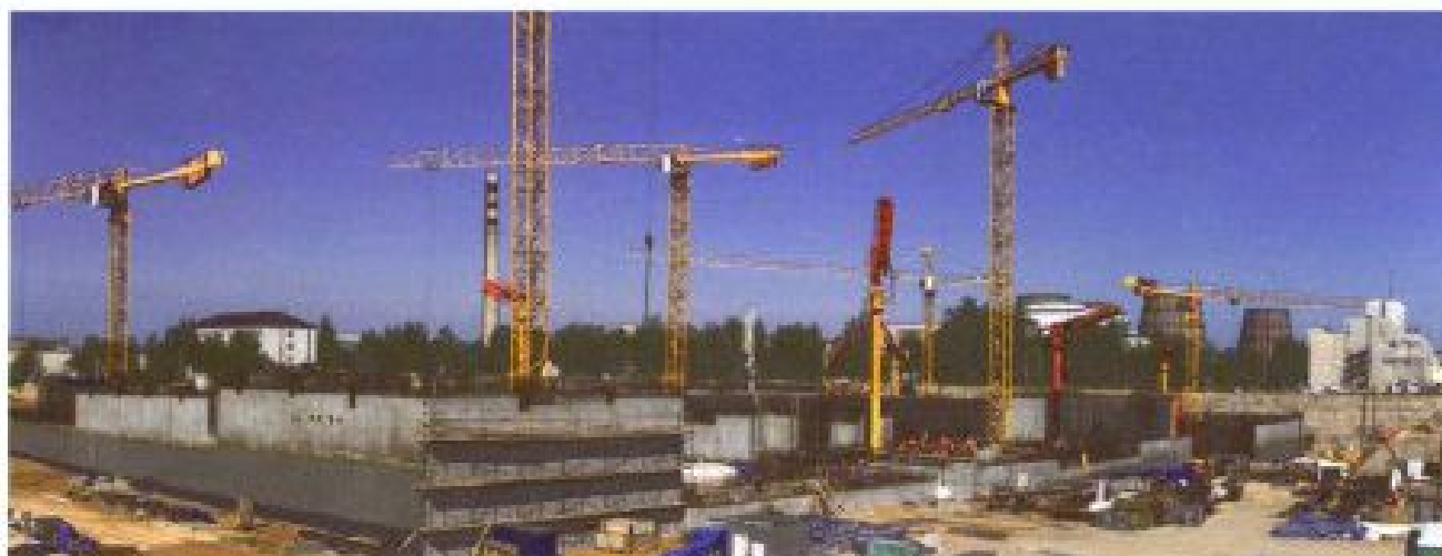
Площадка сооружения реактора МБИР (август, 2016 год)
