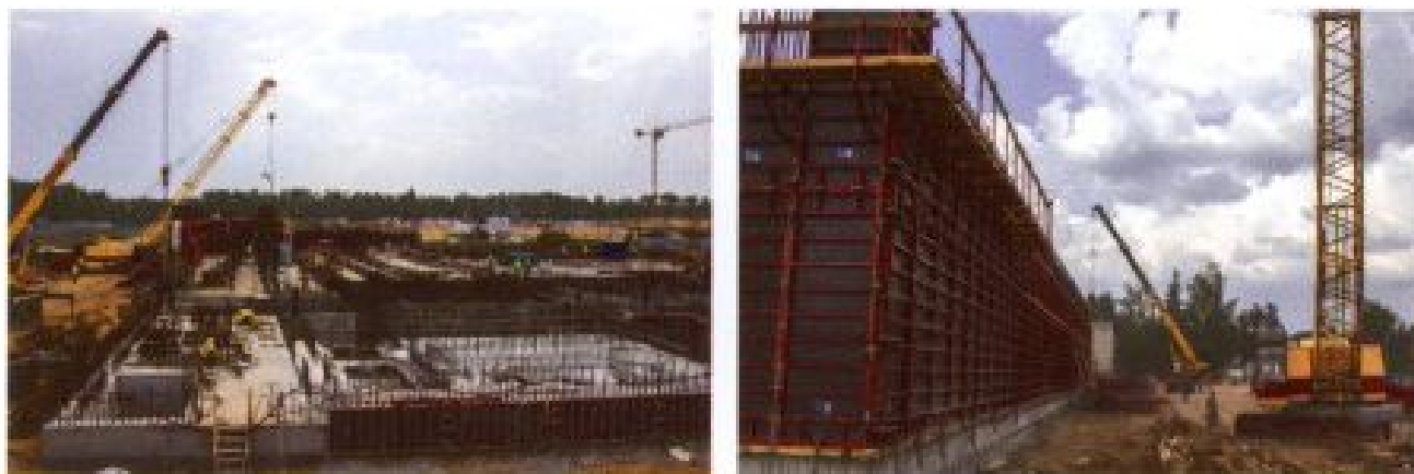
Строительство полифункционального исследовательского радиохимического комплекса
