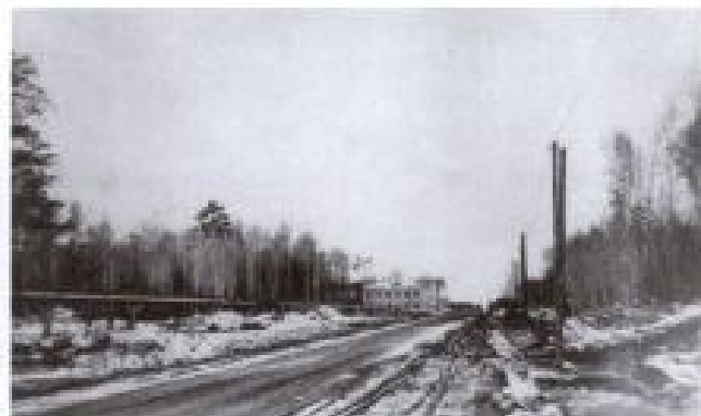
Дорога на промплощадку и теплотрасса
