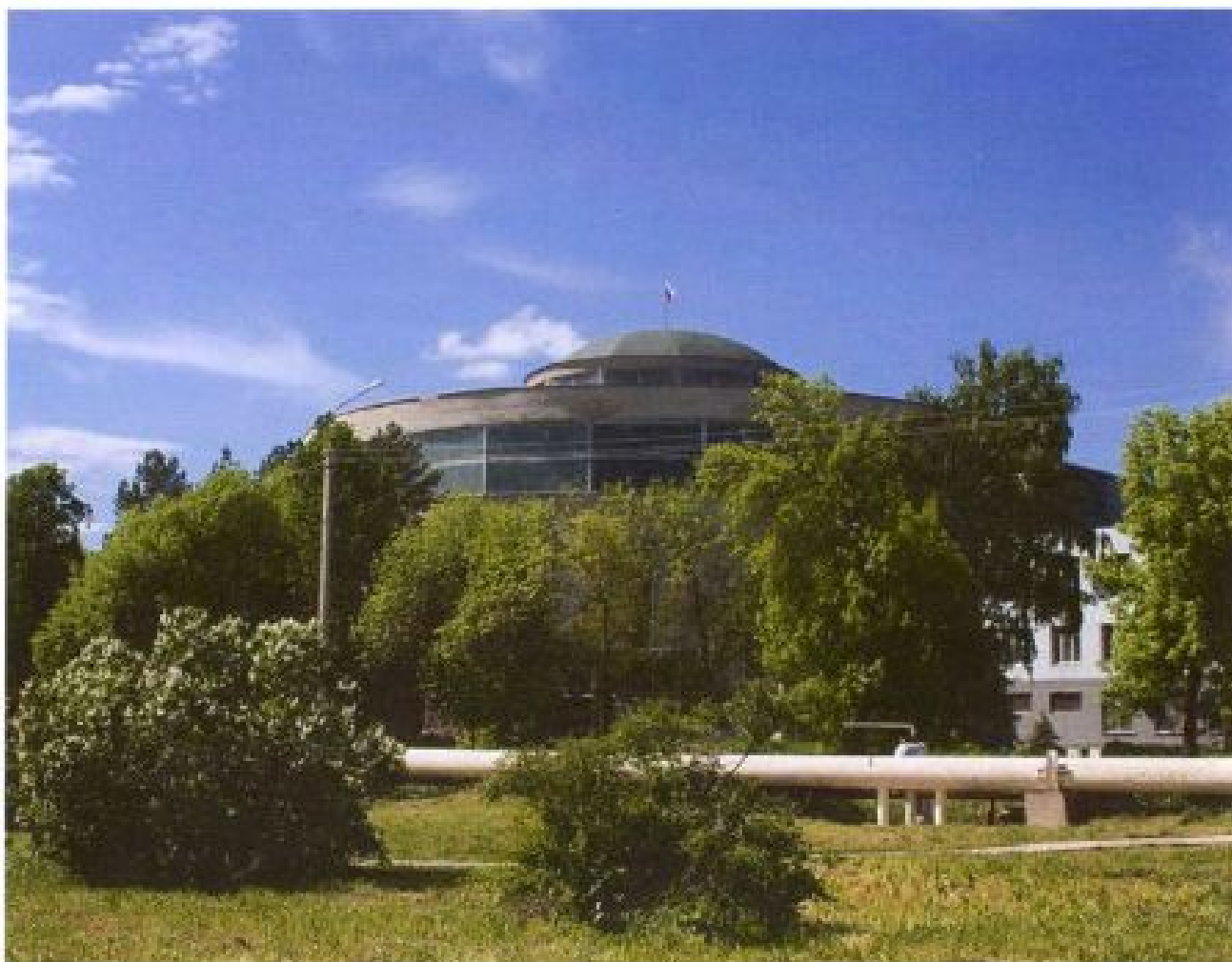
Внешний вид здания реактора МИР
