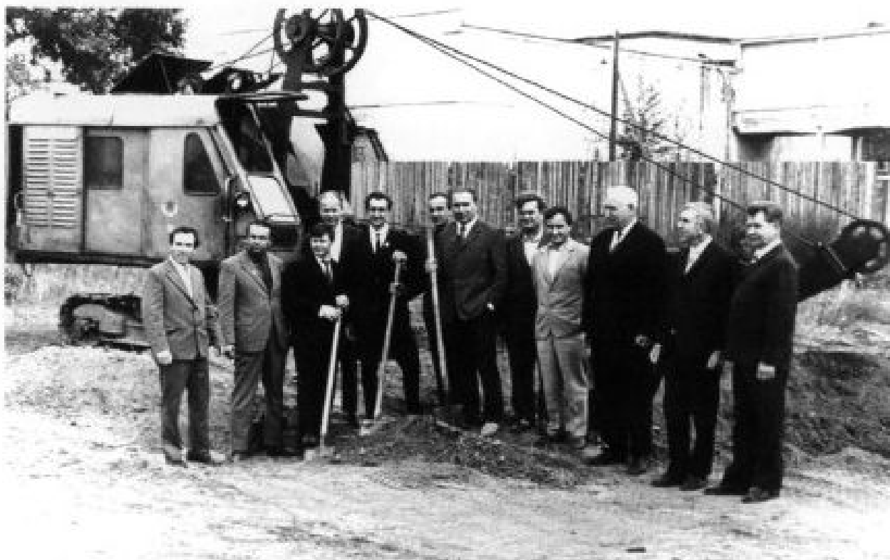
Начало строительства здания установки «Орёл»
