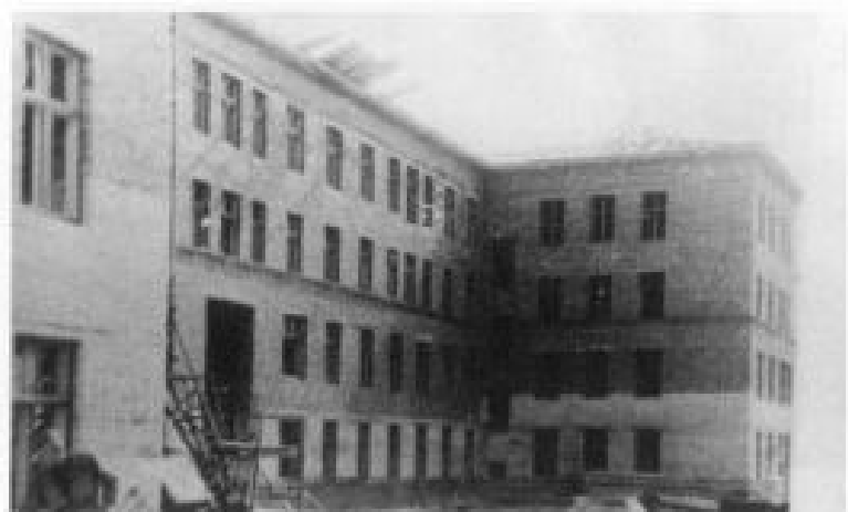
Главный корпус МСЧ-65
