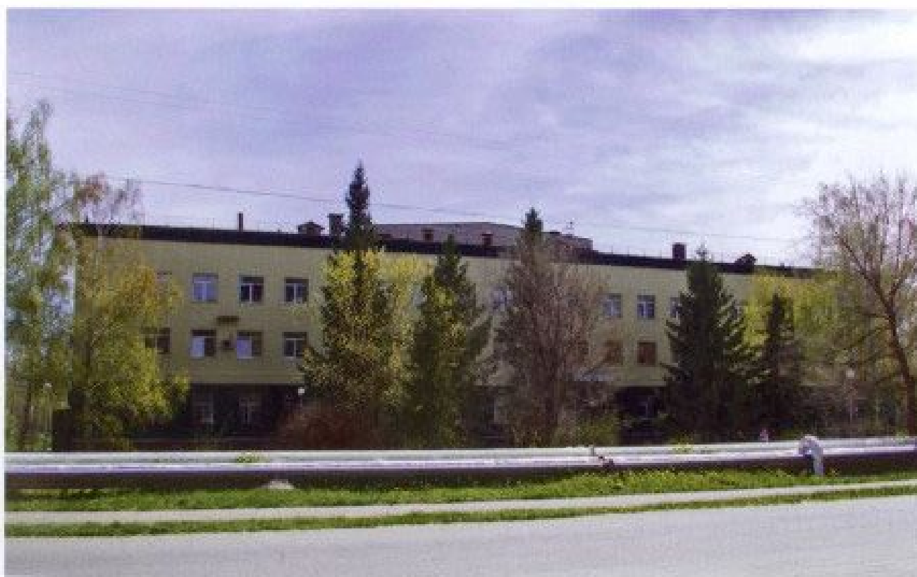
Общий вид здания радиохимического комплекса
