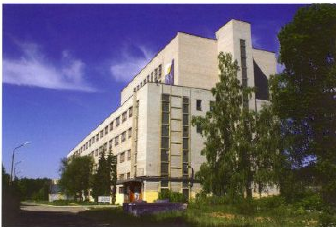
Внешний вид здания реактора ВК-50
