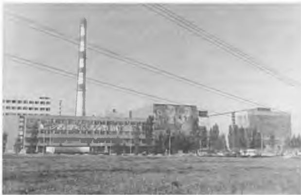
Общий вид на III и IV блоки
