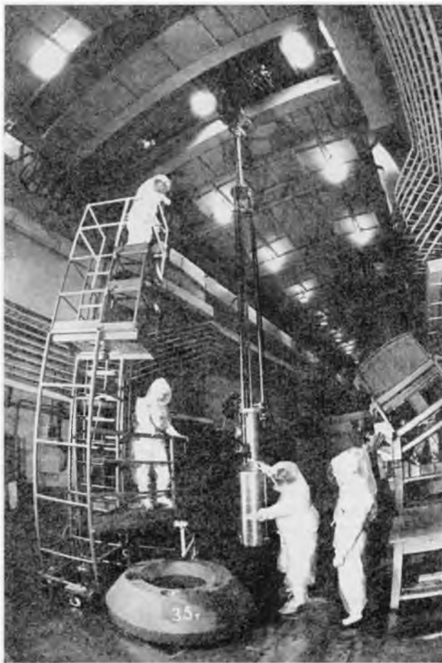
Регламентная работа на реакторе ИБР-2 по догрузке активной зоны
