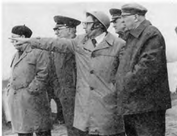
Площадка Томского нефтехимического комбината, май 1978 г. Справа налево: министр Минсредмаша СССР Е.П. Славский, заместитель министра П.К. Георгиевский, начальник строительства П.Г. Пронягин, главный инженер ГУКС В.В. Киреев, начальник 10-го Главного управления И.Е. Дерябин
