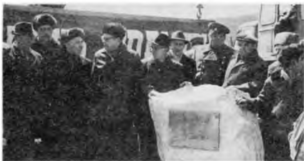
Закладка телевизионной станции «Орбита», г. Краснокаменск.
