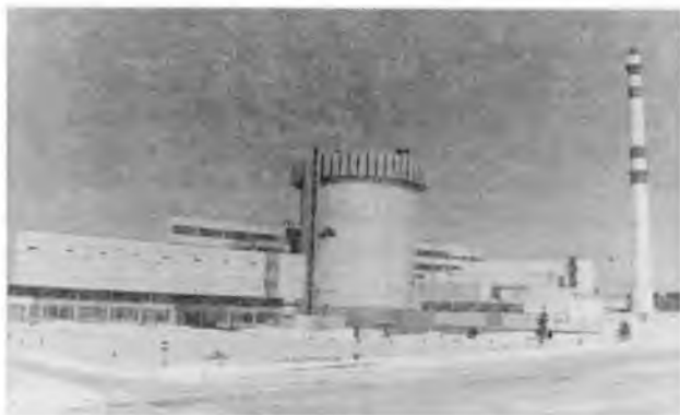
Общий вид V блока
