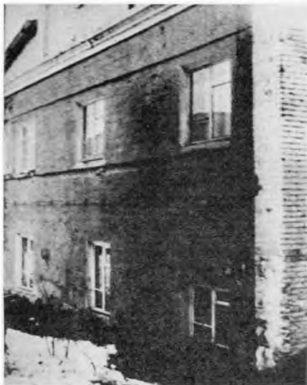
Первое здание ОКБ «Гидропресс», 1947 г.
