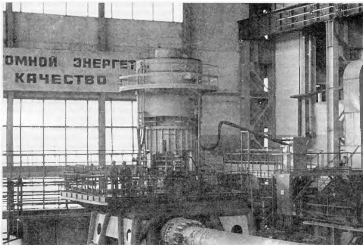
Насос ГЦН-195М для АЭС с ВВЭР-1000 на испытаниях
