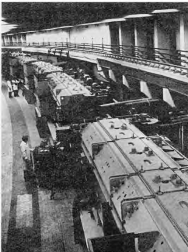
Кольцевой зал протонного синхротрона ИФВЭ У-70 с энергией 70 млрд эВ. Введен в 1967 г.
