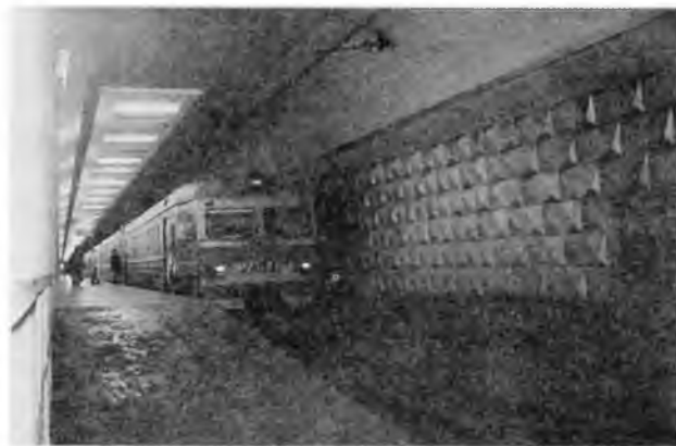
Посадочная платформа электропоезда в подземных сооружениях
