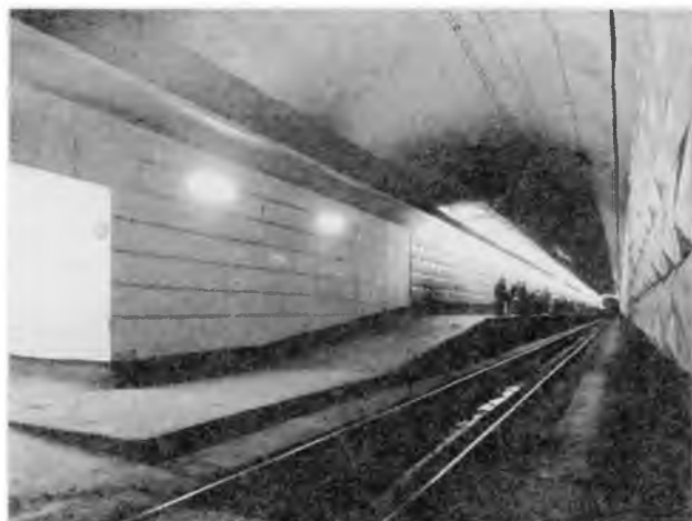
Посадочная платформа электропоезда в подземных сооружениях
