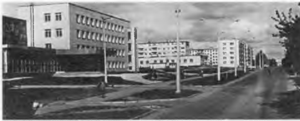
Город Лесной, музыкальная школа, крупнопанельные жилые дома собственного изготовления
