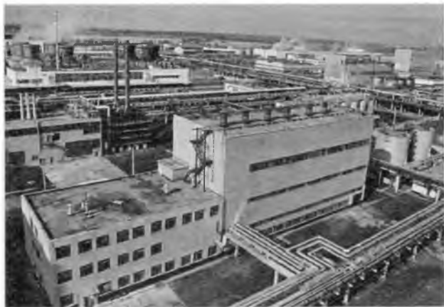
Зиминский химический завод
