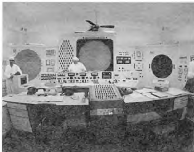
Пульт управления реактора АВ-2
