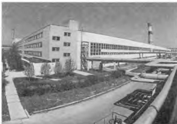
Корпус № 274 АООТ МСЗ
