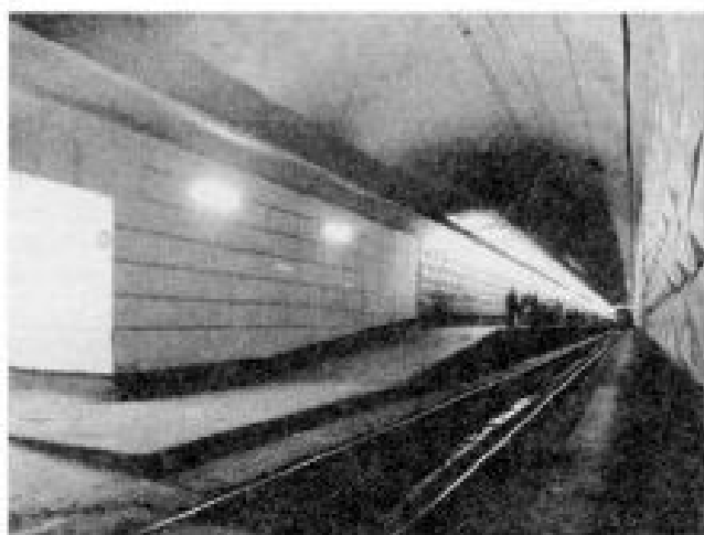
Посадочная платформа электропоезда в подземных сооружениях
