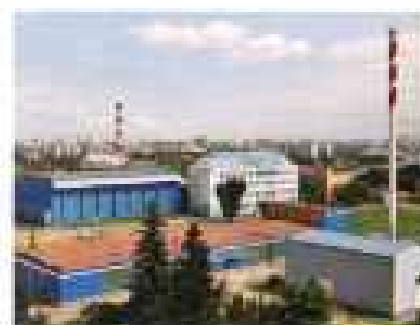
Территория предприятия: АБК № 90, котельная
