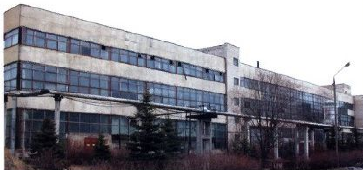
Экспериментальный корпус для теплофизических испытаний космических ядерных энергетических установок и теплообменных устройств
