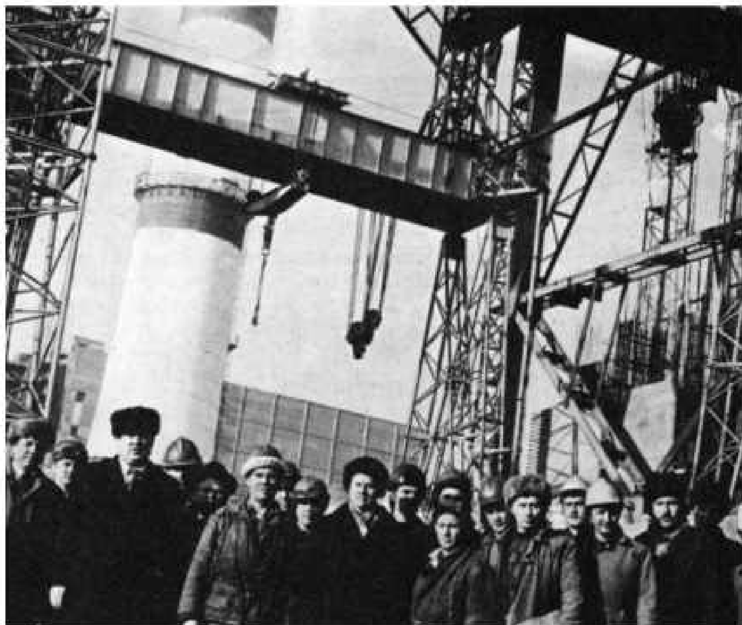
Дерзкий замысел осуществлен: эстакада на новом месте — без демонтажа!
