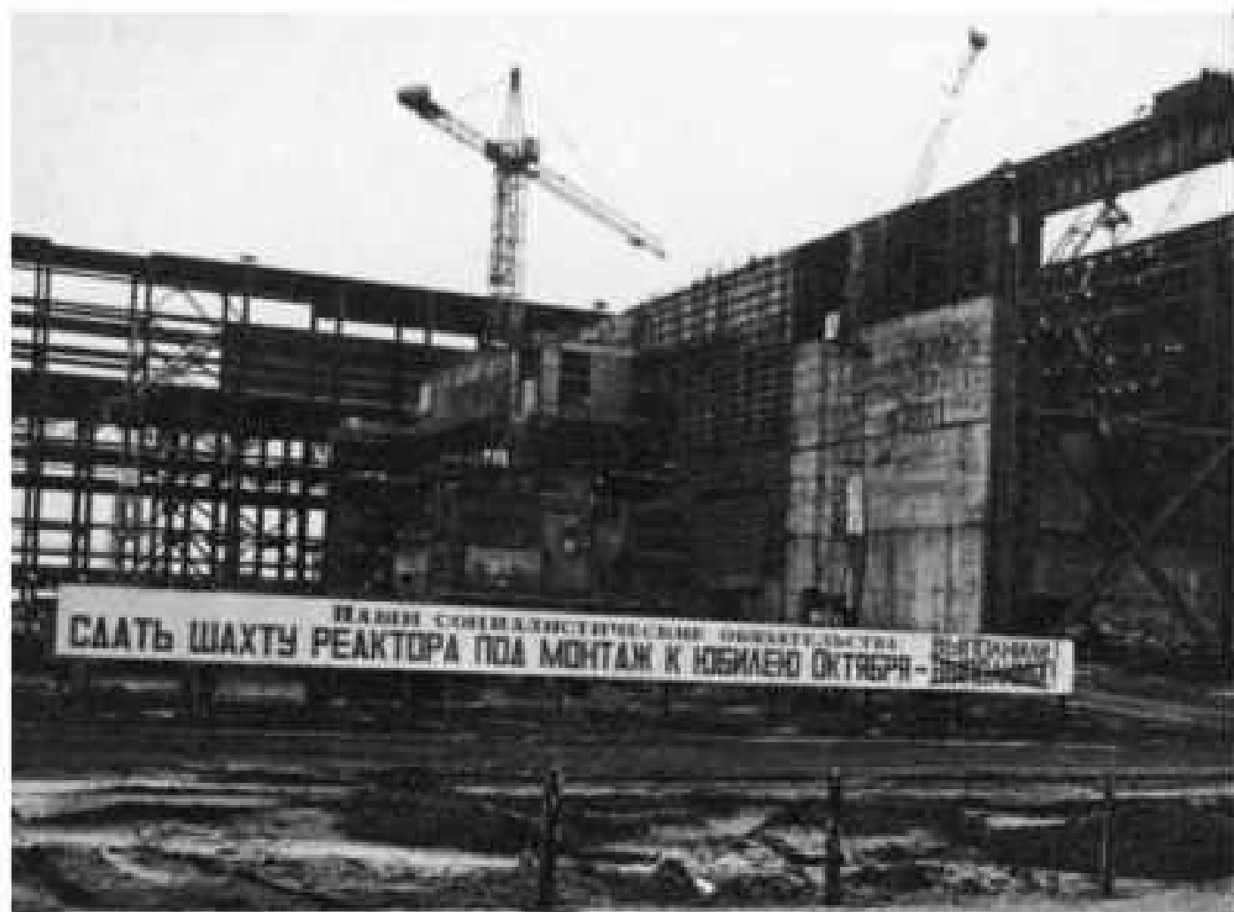
Шахта реактора третьего энергоблока сдана под монтаж
