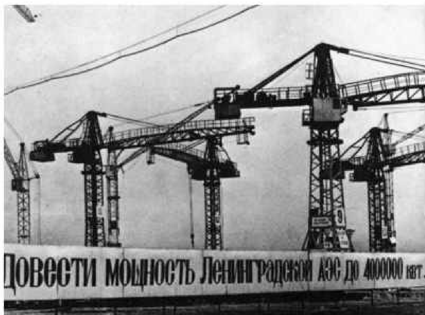
Строится вторая очередь Ленинградской АЭС
