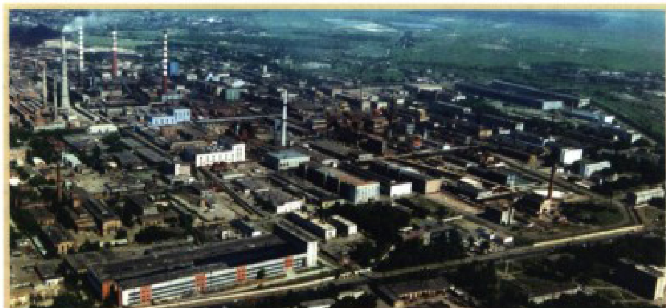
Ульяновский металлургический завод (Казахстан)
