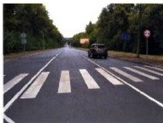
УЛ. ЗАВОДСКАЯ – СВЕЖАЯ РАЗМЕТКА НА ОТРЕМОНТИРОВАННОЙ ДОРОГЕ
