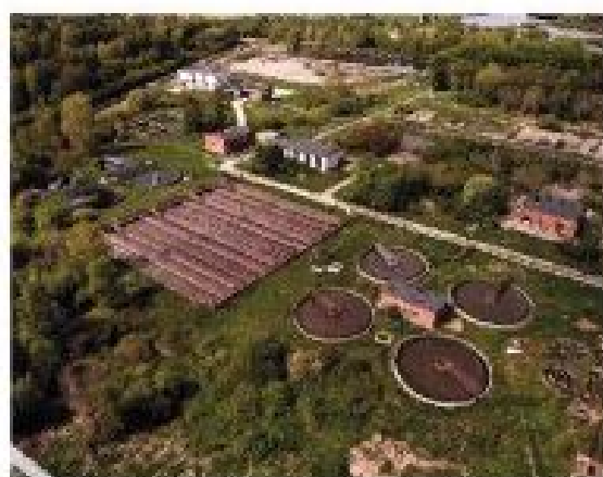
ОЧИСТНЫЕ СООРУЖЕНИЯ КАНАЛИЗАЦИИ (АЭРОТЕНКИ)
