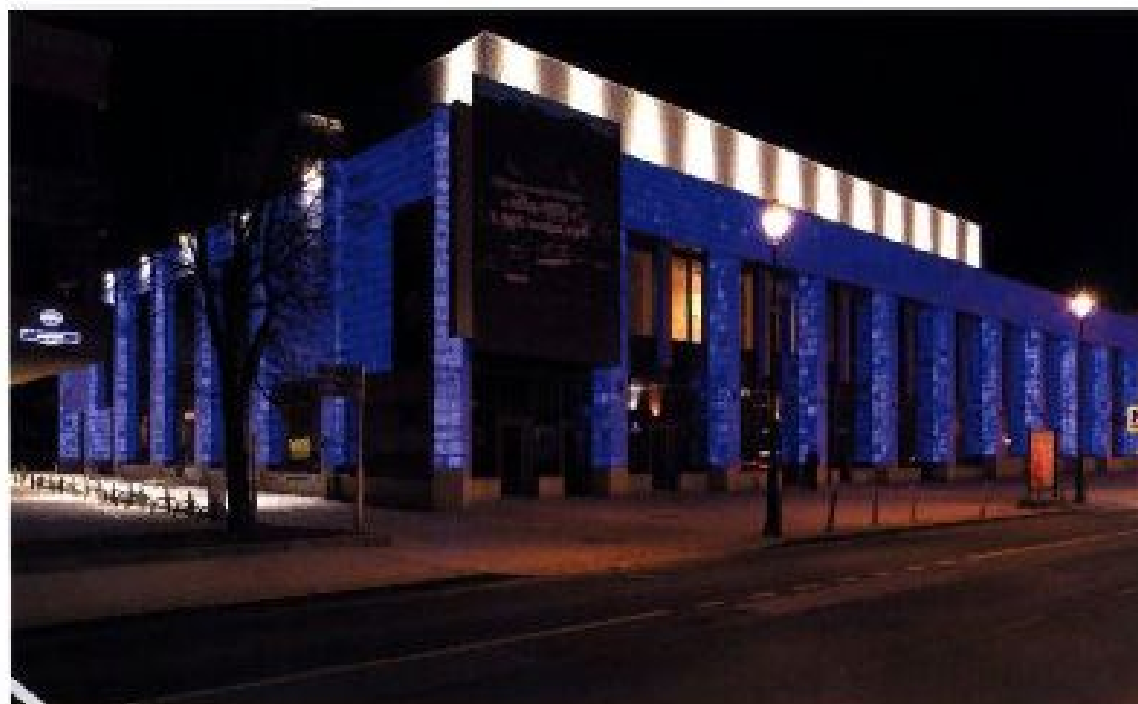
ФАСАД ЦЕНТРАЛЬНОГО ДОМА ПРЕДПРИНИМАТЕЛЯ (Г. МОСКВА) СДЕЛАН ИЗ СВЕТОПРОВОДЯЩЕГО БЕТОНА
