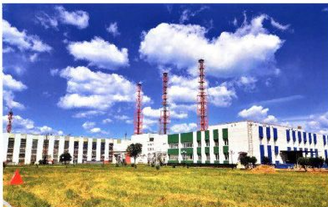
ТРУБЫ ЗАВОДА МИНЕРАЛЬНЫХ УДОБРЕНИЙ
