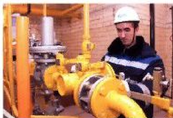
В 2017 г. завершилась реконструкция газораспределительного пункта в г. Кирово-Чепецке
