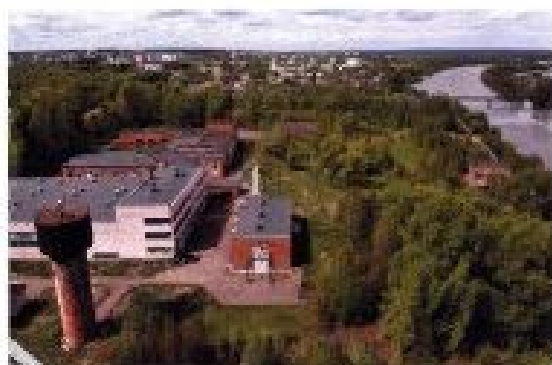
ОЧИСТНЫЕ СООРУЖЕНИЯ ВОДОЗАБОРА
