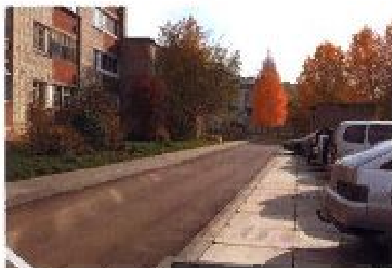
ТРИ НОВЫХ ЭЛЕМЕНТА БЛАГОУСТРОЙСТВА В ОДНОМ ДВОРЕ ПО УЛ. МОЛОДЕЖНОЙ: ТРОТУАР, ПРОЕЗД, ПАРКОВКА
