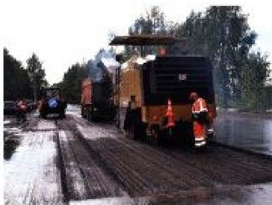
РЕМОНТ ДОРОЖНОГО ПОЛОТНА НА ВЯТСКОЙ НАБЕРЕЖНОЙ
