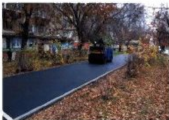
НОВЫЙ АСФАЛЬТ НА ТРОТУАРЕ ПО ПР-ТУ МИРА
