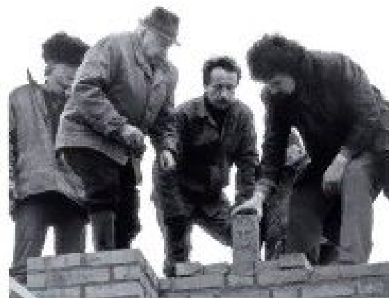
УСТАНОВКА ЗАКЛАДНОГО КАМНЯ В СТЕНУ СТРОЯЩЕГОСЯ ВСЕХСВЯТСКОГО СОБОРА, 20.04.1992
