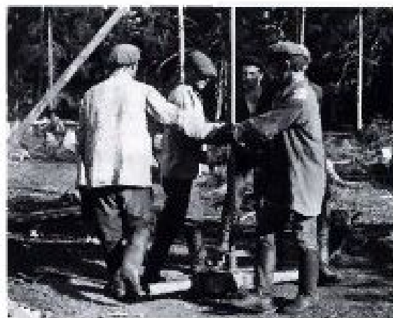
ГЕОЛОГОРАЗВЕДКА МЕСТА ДЛЯ СТРОИТЕЛЬСТВА ТЭЦ, 1936 Г.
