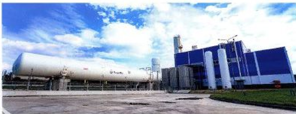
ЗДАНИЕ АЗОТНОЙ СТАНЦИИ
