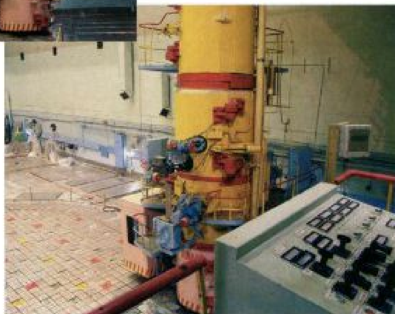
Разгрузочно-загрузочная машина для РБМК
