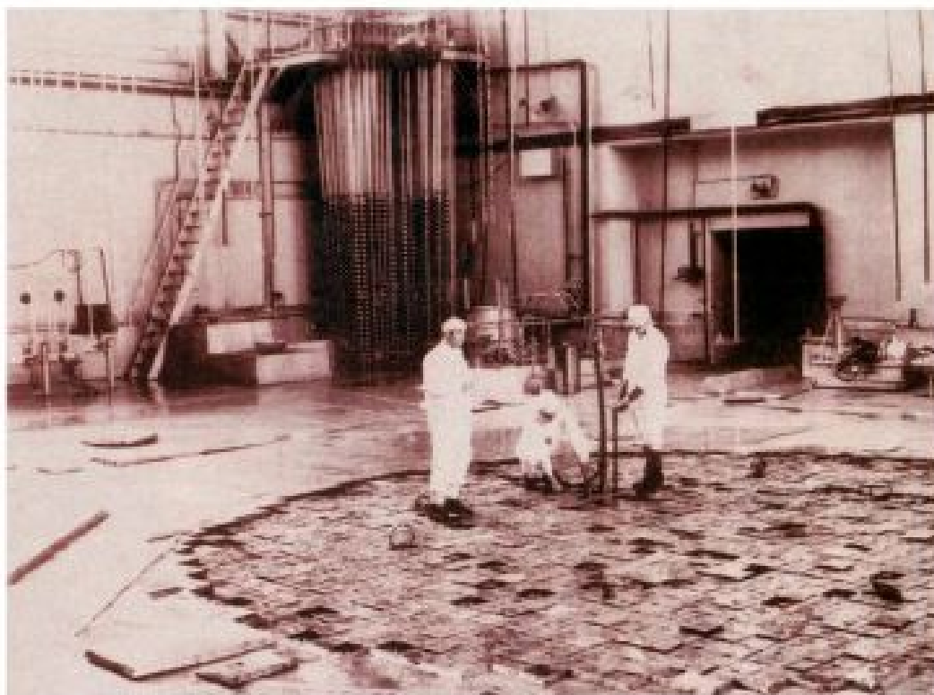
Центральный зал реактора «А» проектной мощностью 100 МВт. Реактор введен в 1948 г. на комбинате «Маяк».
