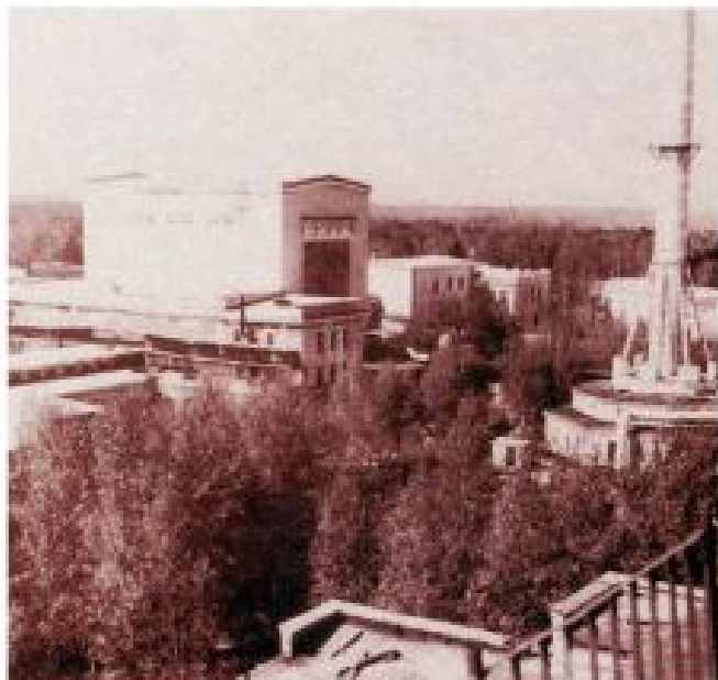
Здание, где размещался первый промышленный реактор «А» (комбинат «Маяк», г. Озёрск)
