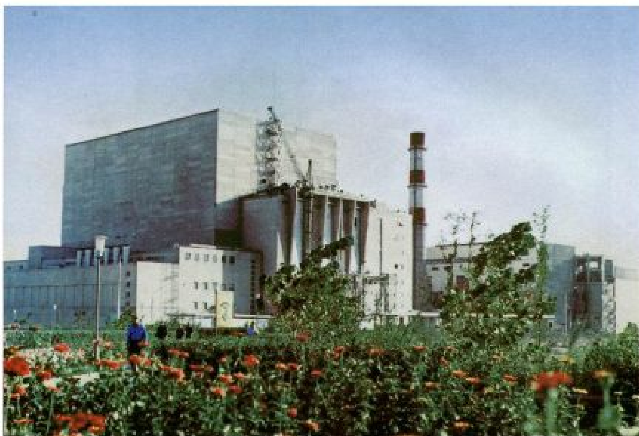
Реактор БН-350. В 1973 г. в городе Шевченко была построена первая в СССР атомная станция с реактором на быстрых нейтронах БН-350. Тепловая мощность составляла 1000 МВт, электрическая – 350 МВт.
