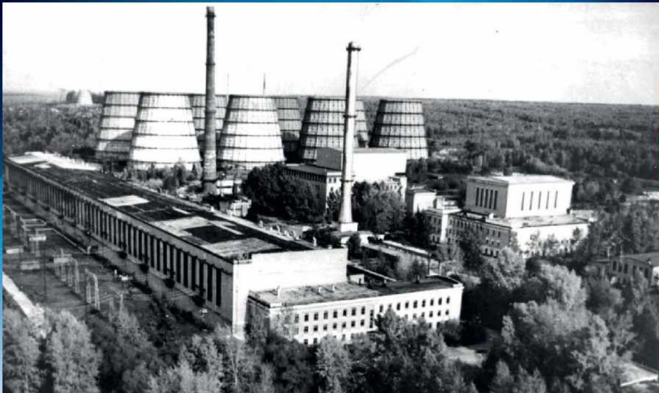
Энергокомплекс Сибирской АЭС имел двухцелевое назначение: наработка оружейного плутония и производство электроэнергии
