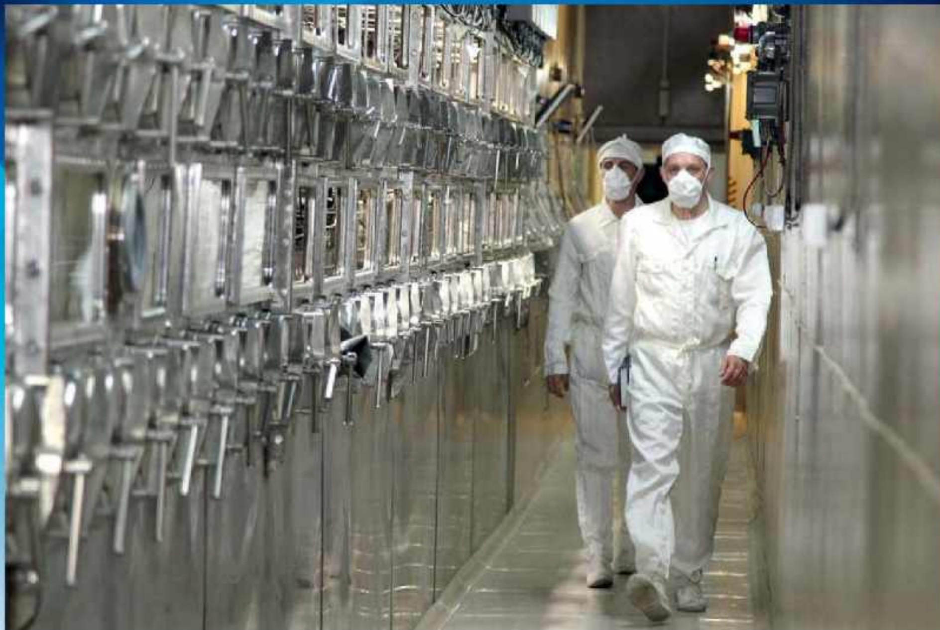
На аффинажном стенде радиохимического завода будут совершенствоваться технологии переработки отработанного ядерного топлива строящегося ОДЭК
