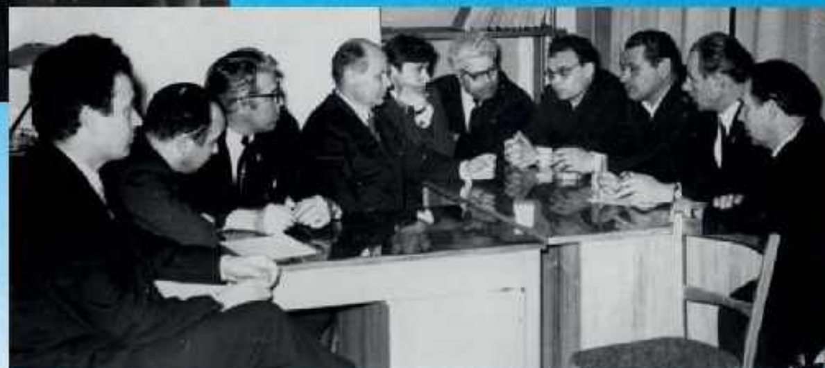
Оперативное совещание по строительству радиохимического завода
