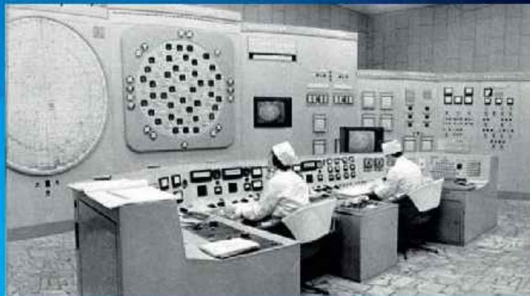
Пульт управления реактора ЭК-3
