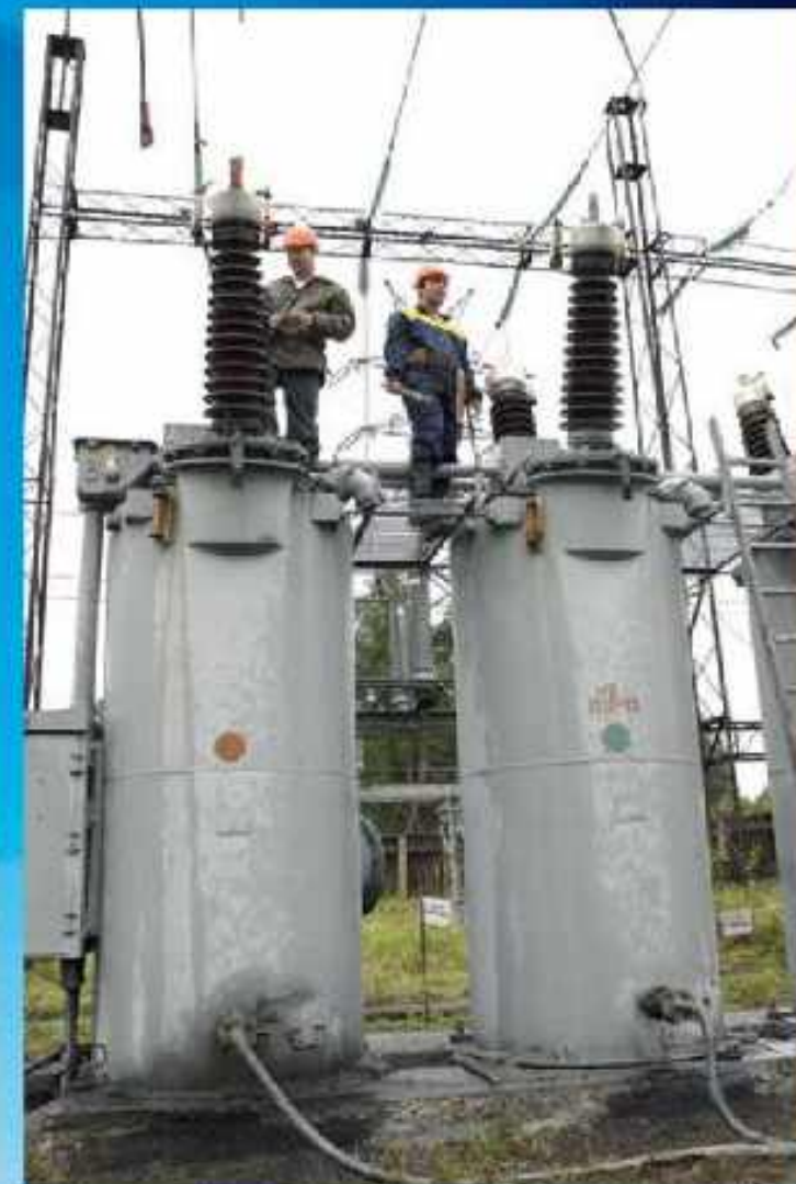
▲ Обслуживание линий электропередач СХК
