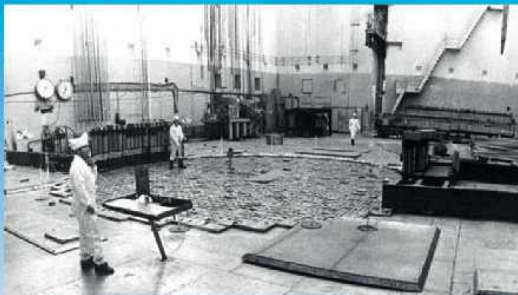
Центральный зал реактора ЭИ-2
