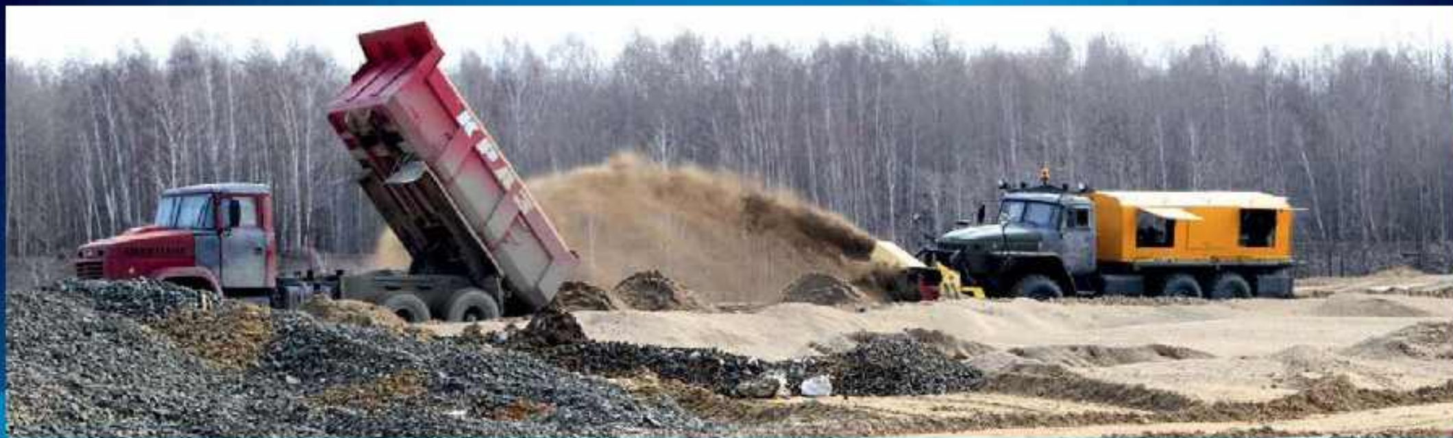
После консервации бассейна Б-1 останется небольшой, засеянный травой, холм
