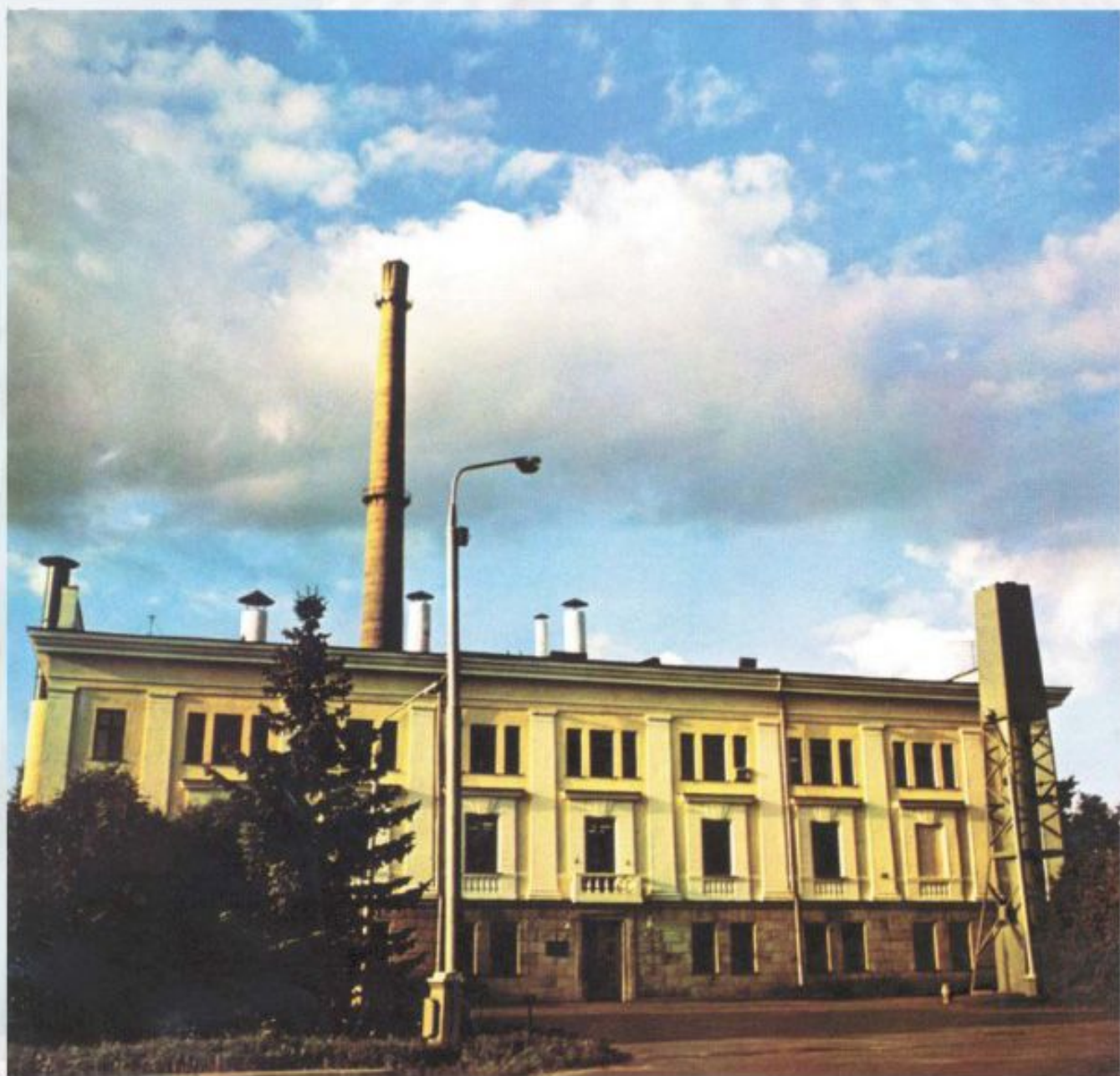
Первая в мире атомная электростанция в г. Обнинске.
