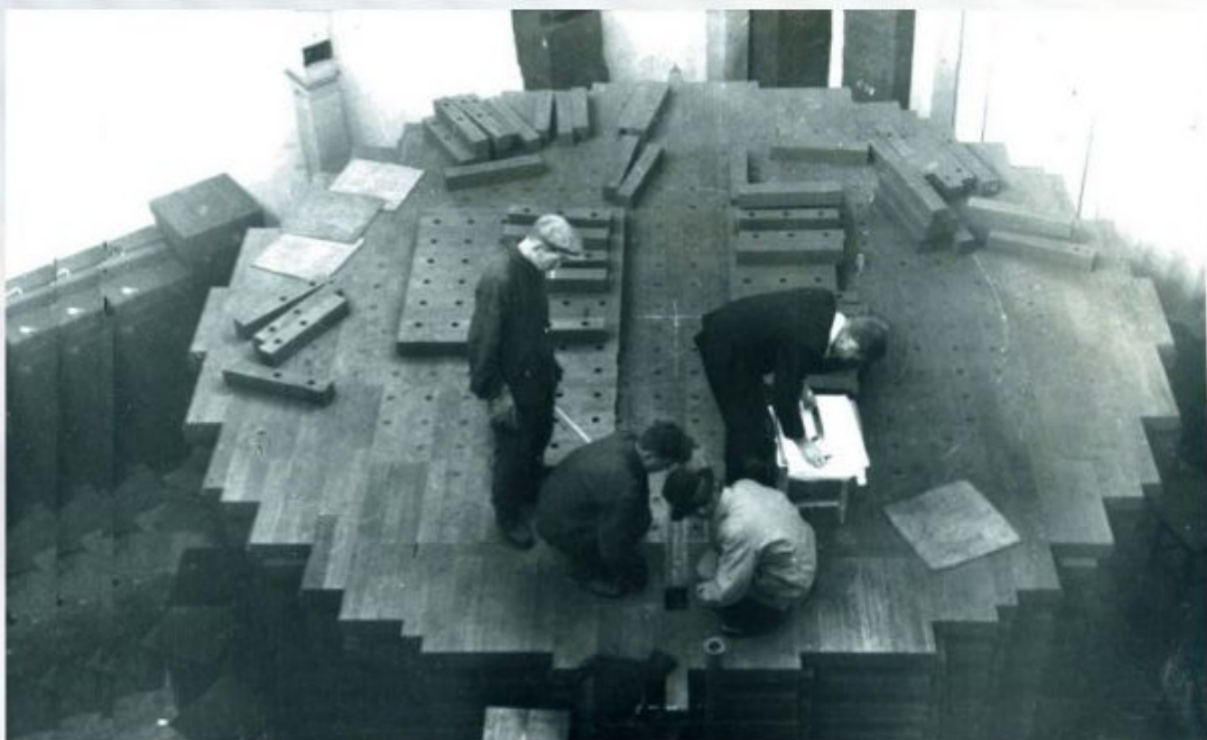
Сборка реактора Ф-1.
