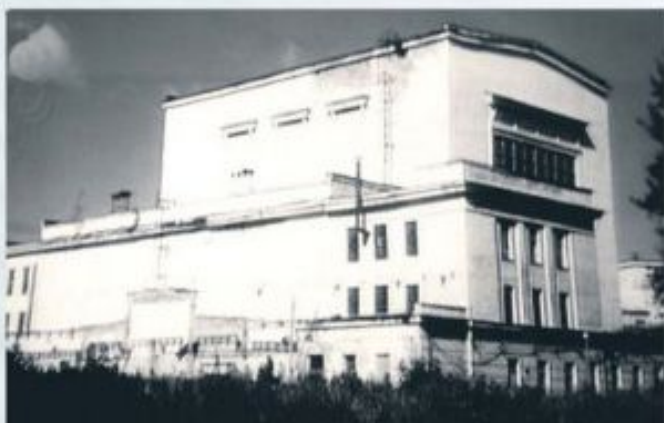
Здание первого промышленного реактора.
