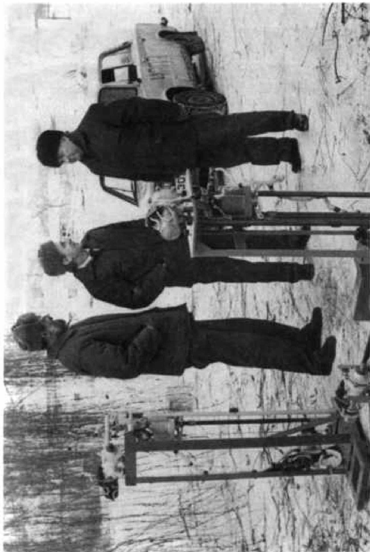
1991 г. Затем роботы испытываются на полигоне и навсегда уезжают в темные помещения “Укрытия”
