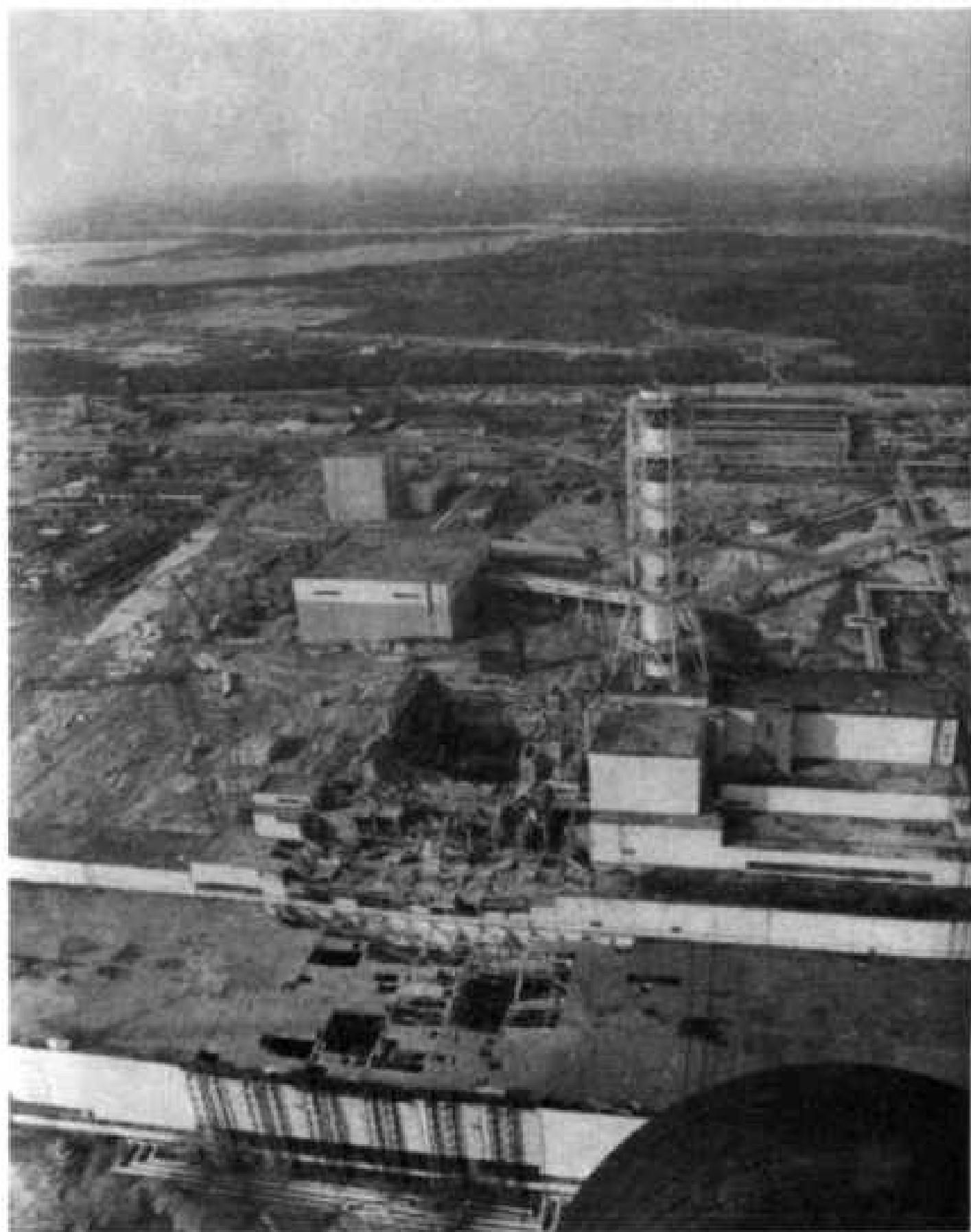
Осень 1986 г. Таким мы увидели разрушенный блок из раскрытой двери вертолета
